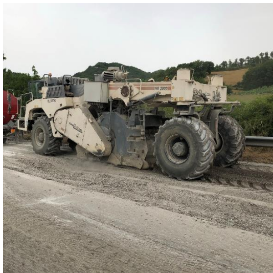
Figura 14 - Foto della miscelazione del fresato con filler e cemento
