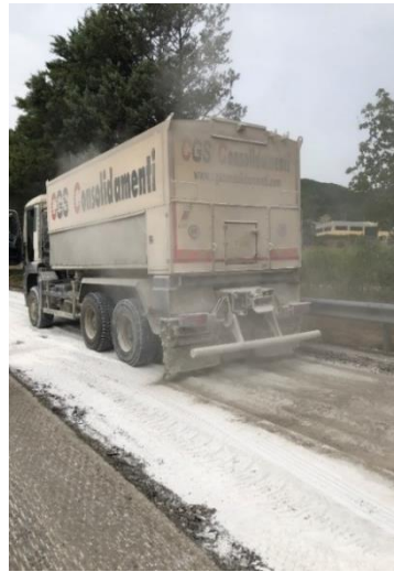
Figura 13 - Foto in cantiere della stesa del filler (sinistra) e del cemento (destra)
