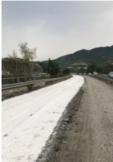
Figura 13 - Foto in cantiere della stesa del filler (sinistra) e del cemento (destra)
