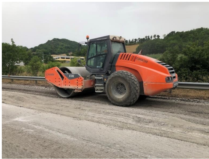
Figura 15 - Foto della compattazione della base a freddo
