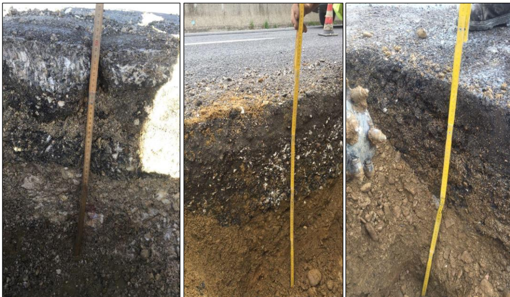
Figura 4 - Foto di prelievi da pozzetti esplorativi
