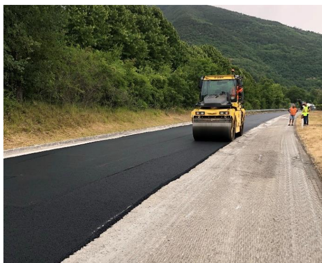
Figura 17 - Foto della compattazione del conglomerato caldo (binder)
