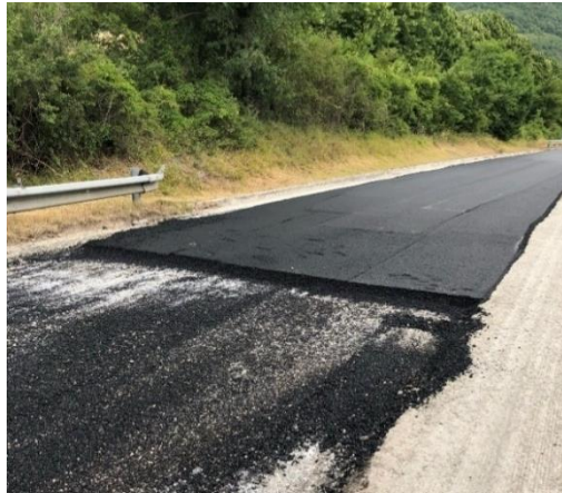
Figura 19 - Foto del giunto trasversale (binder)
