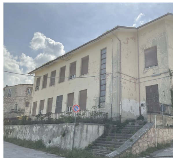
Stato di fatto della struttura, maggio 2022
