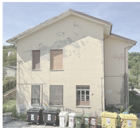
Stato di fatto della struttura, maggio 2022
