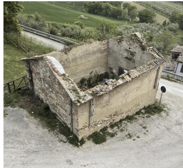
Stato di fatto della struttura, maggio 2022
