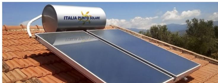
*Fig. 3 - Esempio di pannello solare termico per la produzione di acqua calda [35]*
