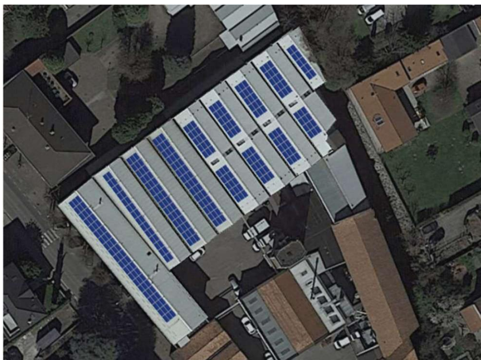
Meda: disposizione 299 moduli FV JA Solar da 410 Wp
