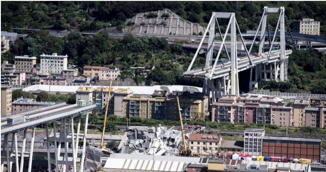
Figura 1.3 Crollo del Ponte Morandi
