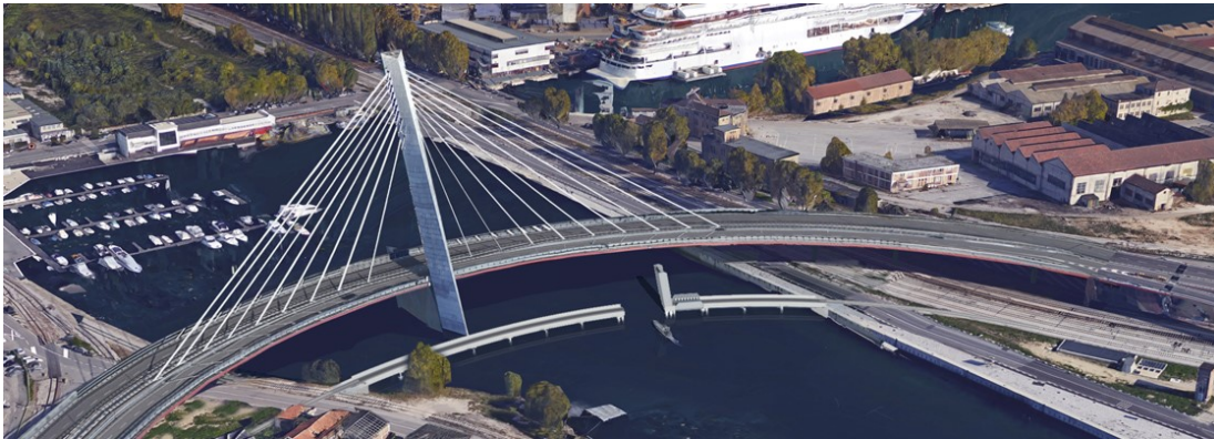
Figura 2.12 Ponte di Marghera
