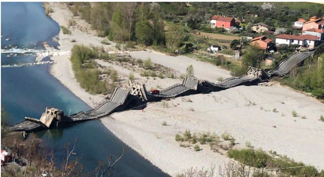
Figura 1.1 Ponte sul Magra
