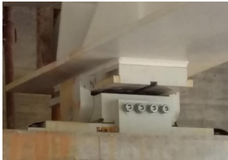
Figura 3.8 Appoggio multidirezionale a carico negativo
