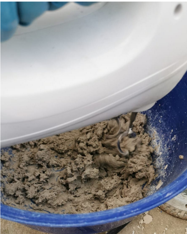
Figura 5.12: miscelazione degli ingredienti con il mixer
