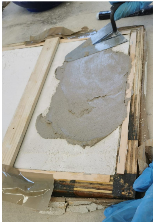
Figura 5.16: stesura della malta ARF a spatola
