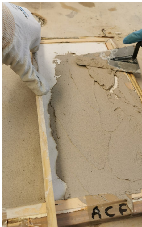
Figura 5.13: stesura a spatola malta ACF
