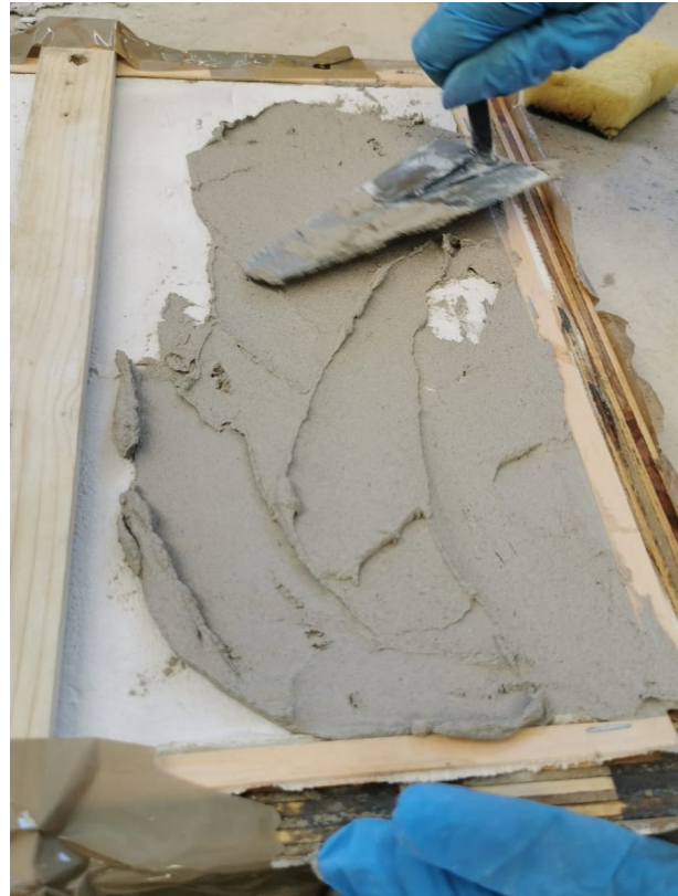
Figura 5.10: stesura del getto ACR mediante spatola
