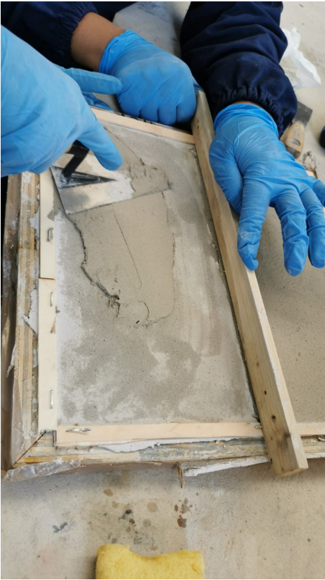
Figura 5.36: stesura a spatola getto ACF.
