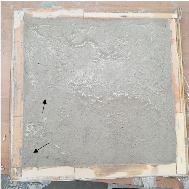
Figura 4.7: Getto con primi segni di fessurazione
