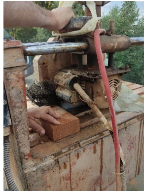
Figura 138_taglio dei mattoni tramite sega ad acqua
