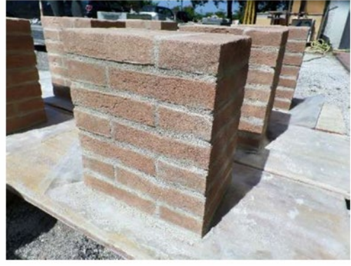
Figura 61_spazzolatura e pulizia della colonna
