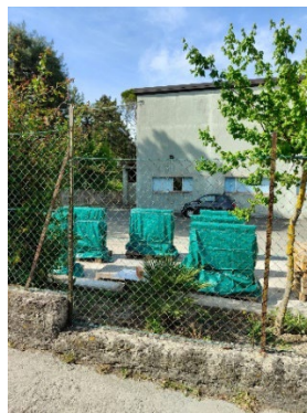
Figura 155_copertura dei muretti in caso di pioggia
