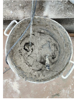
Figura 151_idratazione dei mattoni (sx) e preparazione dell'impasto della malta (dx)
