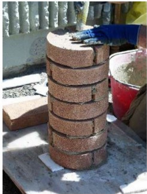
Figura 62_posa del primo strato di allettamento e controllo della planarità
