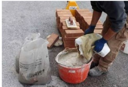
Figura 33_peso della sabbia (sx) e inserimento della malta nell'impasto (dx)
