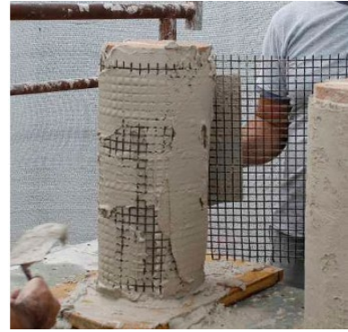
Figura 71_posa del secondo strato di rete e schiacciamento con la spatola
