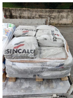
Figura 128_ malta Mape Antique e sabbia del Po Esincalce usate per l'impasto della malta
