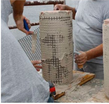
Figura 71_posa del secondo strato di rete e schiacciamento con la spatola
