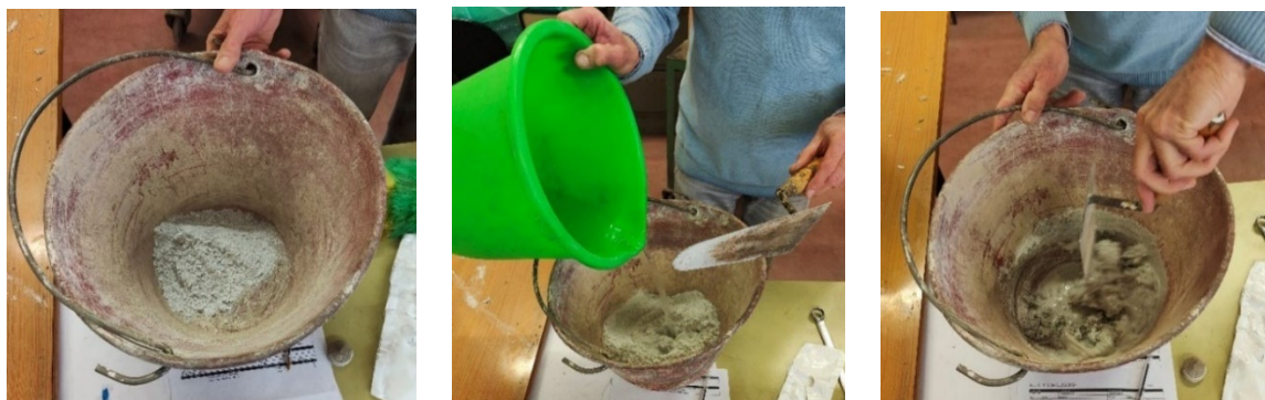
Figura 80_preparazione dell'impasto di gesso
