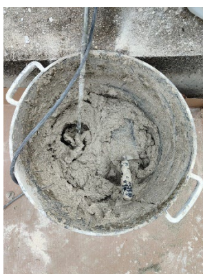
Figura 129_impasto della malta finito
