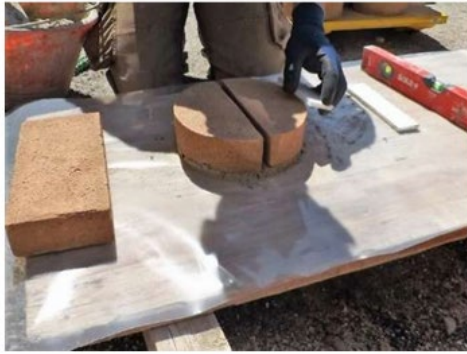
Figura 62_posa del primo strato di allettamento e controllo della planarità
