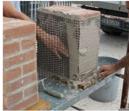
Figura 70_posa del primo strato di rete e applicazione del secondo strato di geomalta
