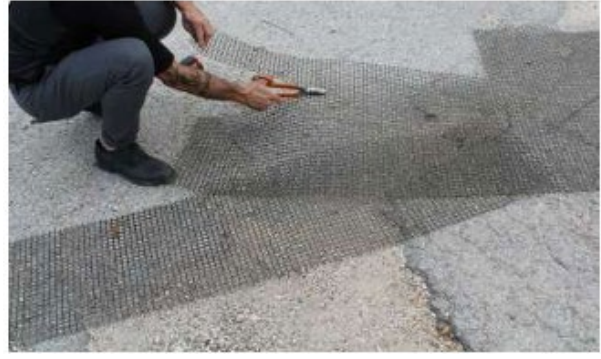
Figura 68_preparazione dell'impasto e taglio della rete
