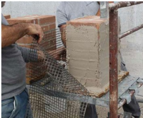
Figura 70_posa del primo strato di rete e applicazione del secondo strato di geomalta
