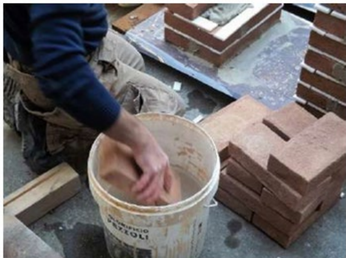
Figura 58_bagnatura dei mattoni e realizzazione della malta
