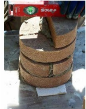
Figura 62_posa del primo strato di allettamento e controllo della planarità
