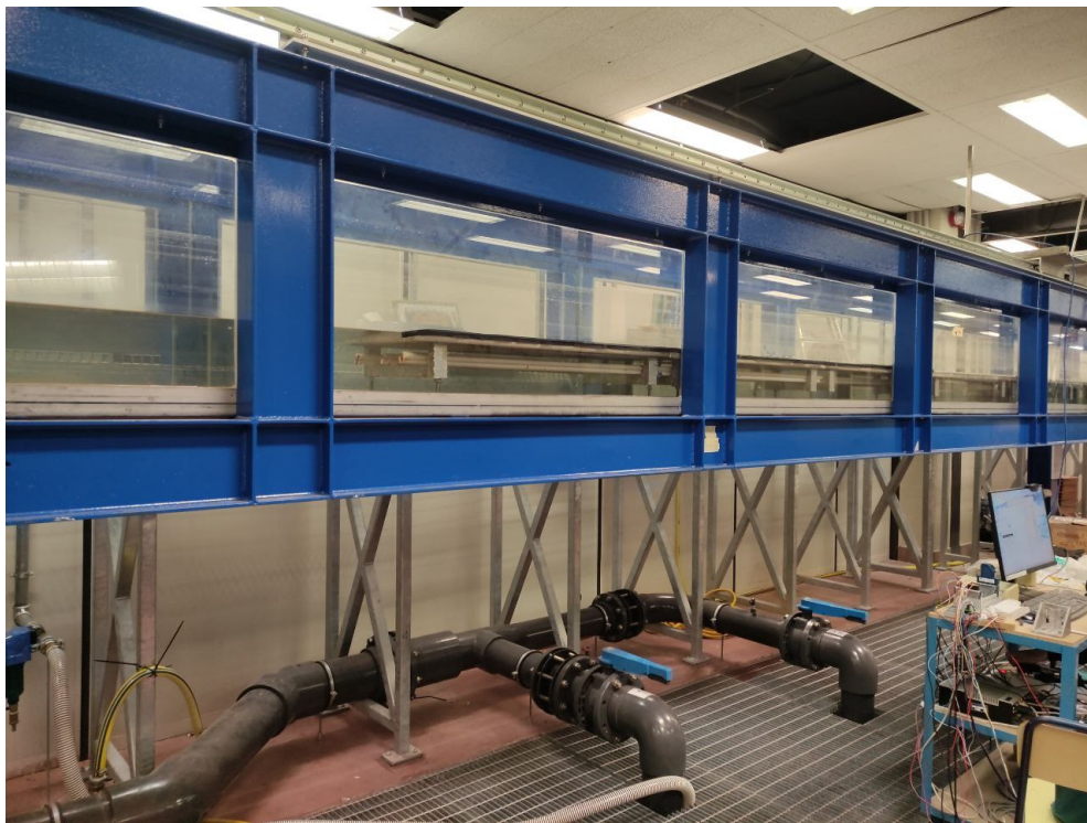
Fig. 6.1.c Porzione centrale del canale idraulico che mostra, in prossimità della griglia a terra, la vasca di raccolta in cui sono posizionate le pompe 1 e 2 (visibile anche la postazione di controllo)
