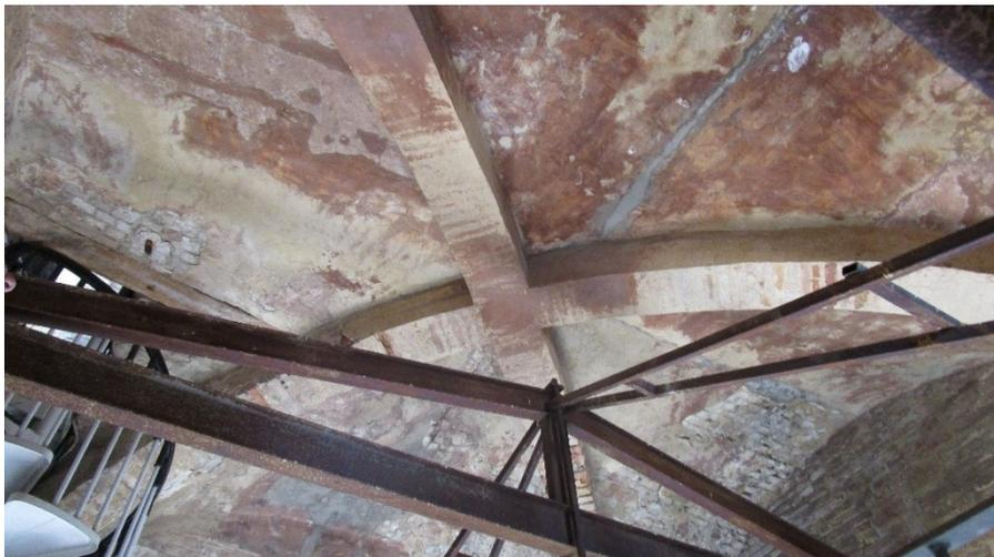
*Figura 3.19 - Livello 6: intonaco distribuito a macchie per nascondere le imperfezioni del paramento murario*
