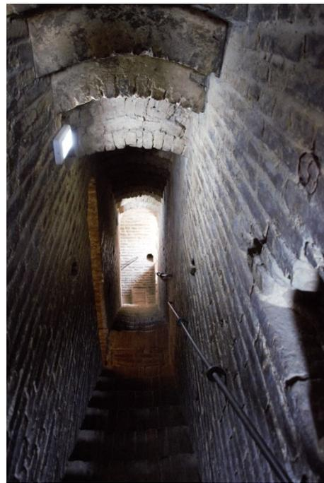
*Figura 3.29 – Il percorso verticale, ricavato nello spessore della muratura, che conduce alle quote superiori*
