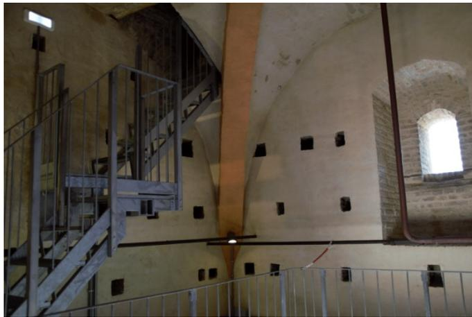
*Figura 3.37 – Livello 6: soppalco grigliato e scala di collegamento con la quota superiore*
