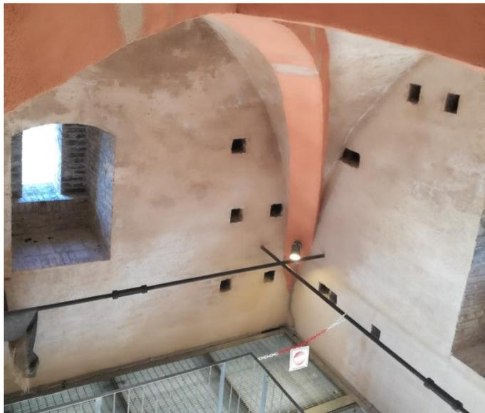
*Figura 3.38 – Dettaglio delle nervature della volta a crociera*
