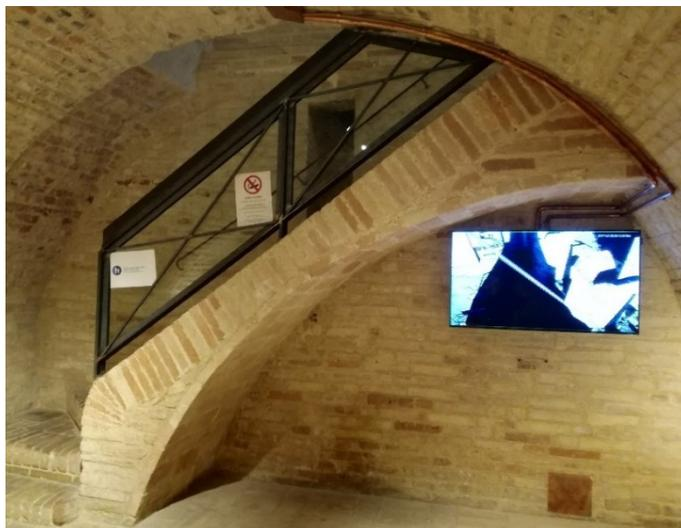
*Figura 3.26 – Primo collegamento verticale: scale su arco rampante*
