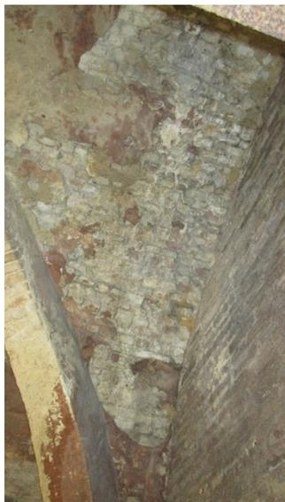
*Figura 3.20 – Livello 6: stato di conservazione delle murature*
