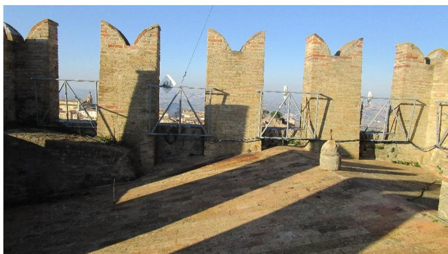
*Figura 3.22 – Livello 7: in primo piano i profili tubolari e le antenne che si alternano tra i merli*
