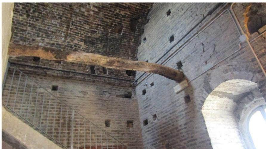
*Figura 3.11 - Livello 3: la trave lignea utilizzata come cavidotto*
