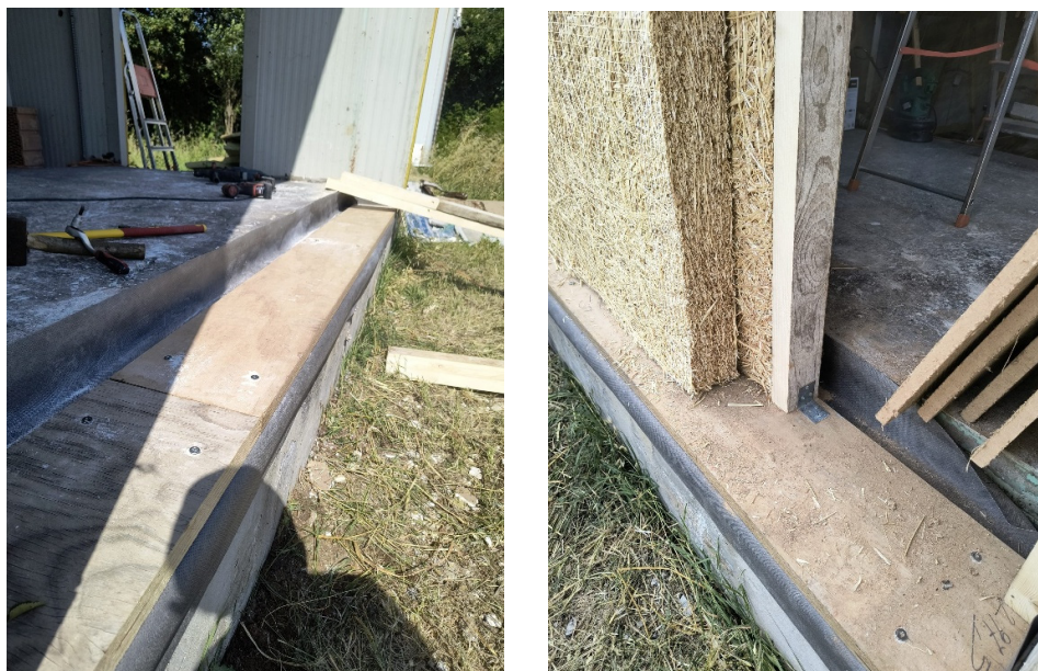
Figura 4.4 - Predisposizione tessuto non tessuto e fissaggio cordolo inferiore in legno
