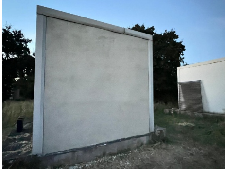
Figura 4.7 - Superficie esterna dopo l'applicazione dell'intonaco in calce esterno
