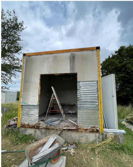
Figura 4.3 - Demolizione della parete esistente
