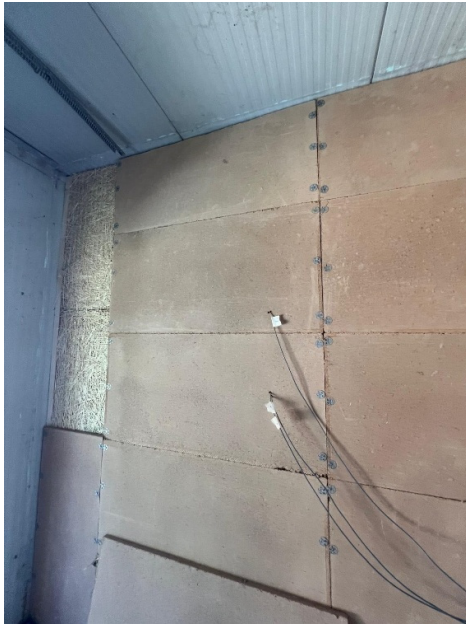
Figura 4.5 - Rivestimento interno in terra cruda
