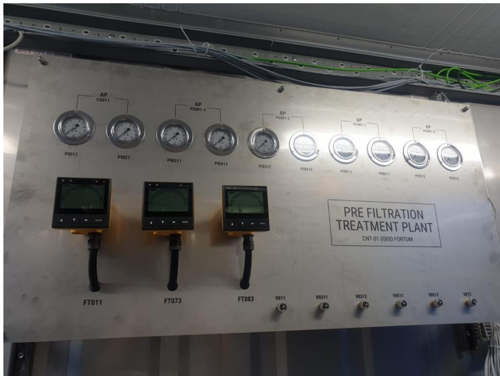
**Figura 2-10: Pannello per Manometri ultimato**
