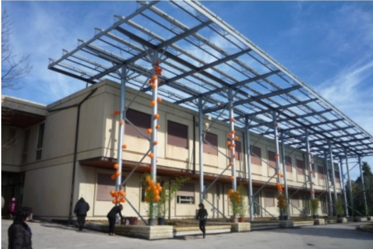
Prospetto sud dell'edificio ove sono visibili le finestre delle aule oggetto di studio al primo piano
