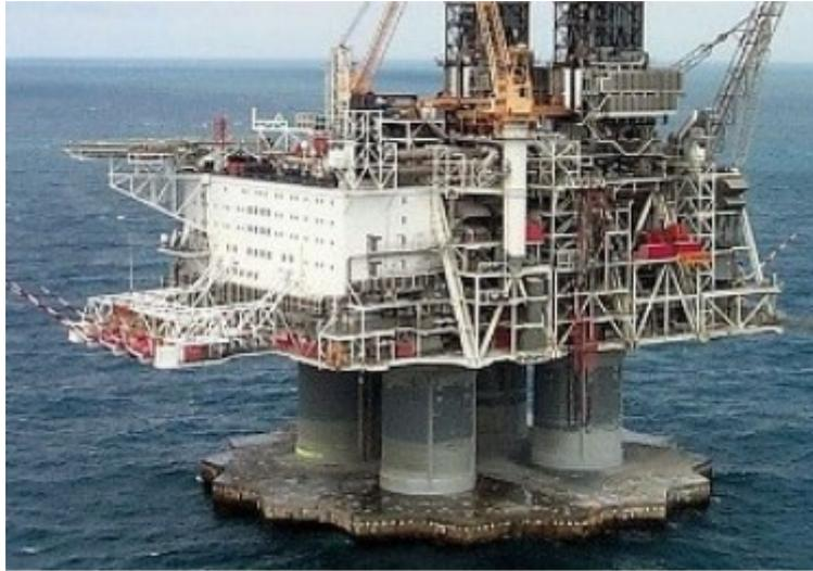
*Figura 2.21 Esempio di gravity base complex.*
