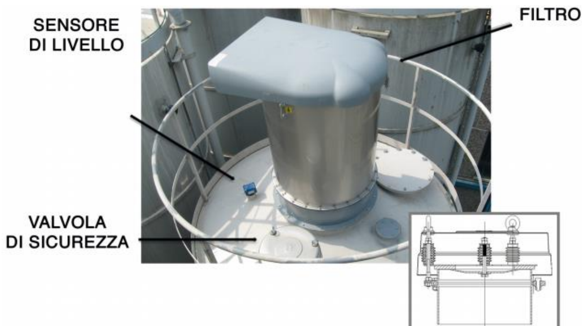
Figura 17 – Sistema di sicurezza silos
