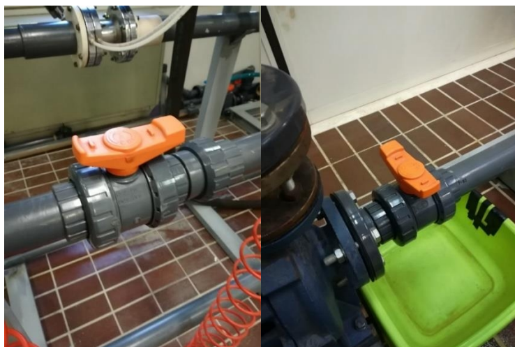
b) Valvola intercettazione 2 vie FIP DN 50 PN 16 (x7 pezzi)
