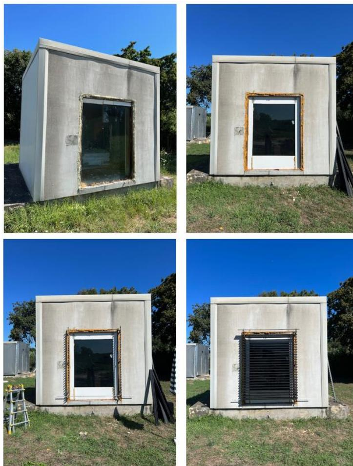
Figura 12. Fasi di installazione schermatura e frangisole
