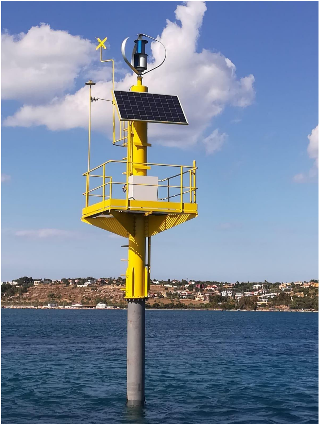
Figura 4 Boa marina con impianto eolico e fotovoltaico
