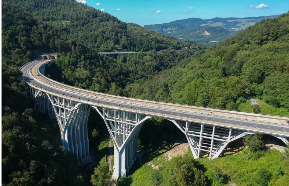
Figura 1.2: Viadotto Poggettone (1957-1960) - A1 Autostarda del Sole (Barberino di Mugello-FI)
