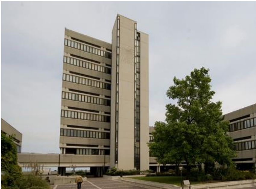
Figura 17 Vista frontale della Torre di Ingegneria dell'Università Politecnica delle Marche.
