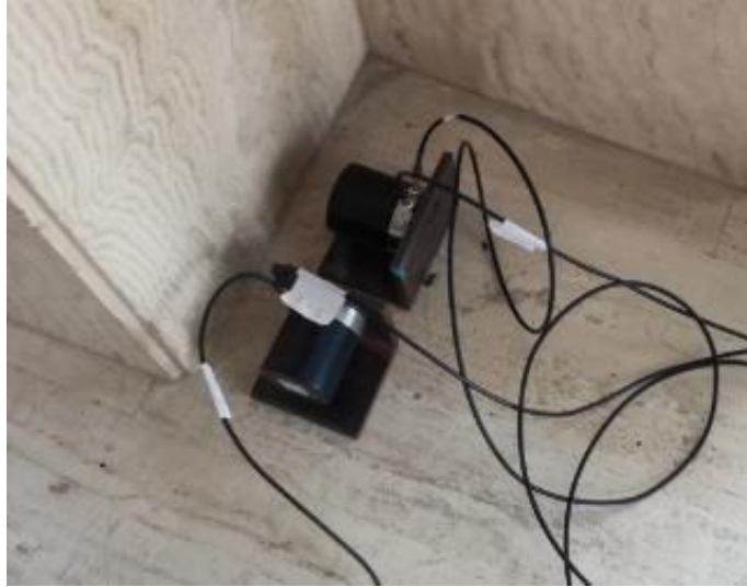
Figura 36 Coppia di accelerometri piezoelettrici situati sul punto C a quota 195 (in direzione X e Y).
