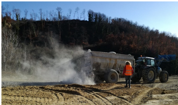
Figura 15: Passaggio della macchina spandi-cemento
