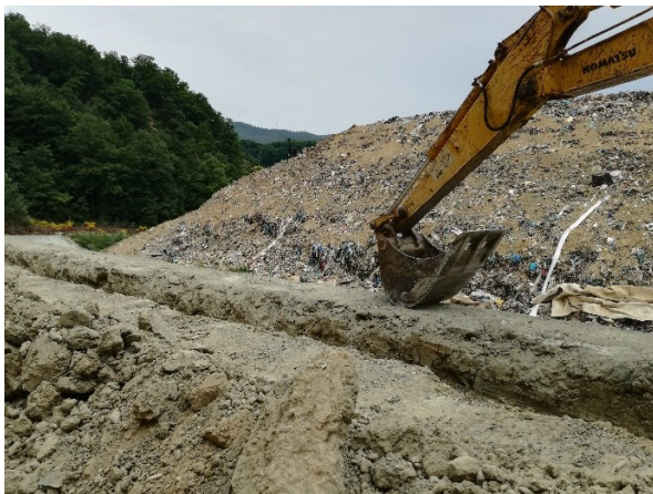
Figura 12: Trincea per fissaggio membrana
