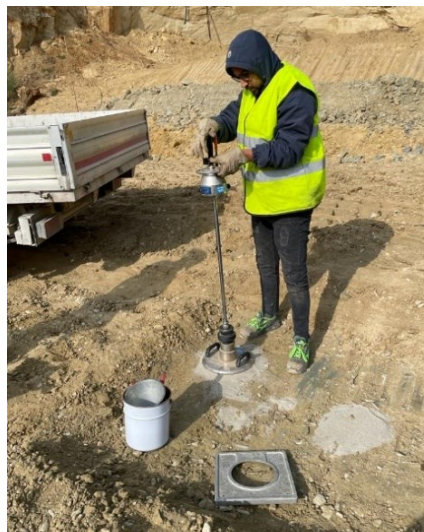
Figura 16: Prova di carico dinamica in sito
