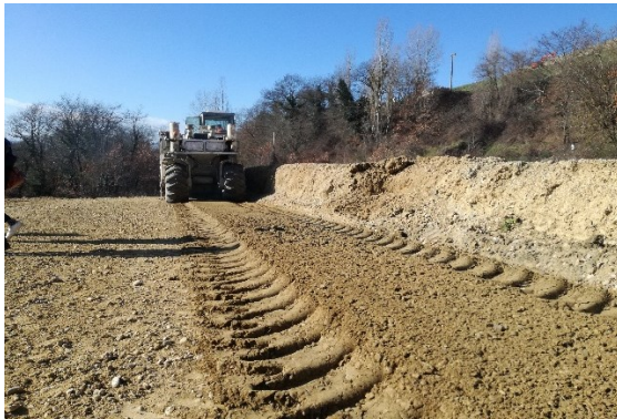
Figura 8: Fresatura del terreno
