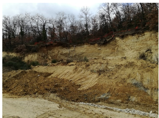
Figura 13: Luogo di costruzione del rilevato
