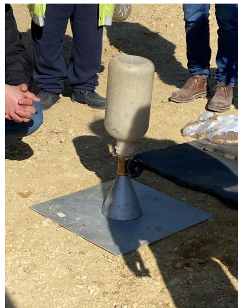
Figura 18: Esecuzione della prova
