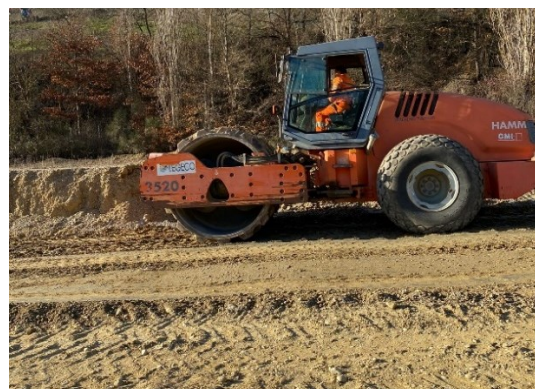
Figura 11: Compattazione dello strato
