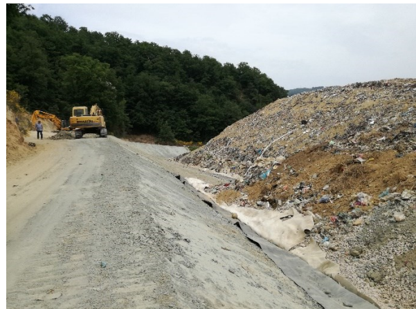
Figura 13: Barriera di fondo discarica
