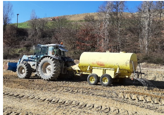
Figura 9: Aggiunta dell'acqua mediante autobotte
