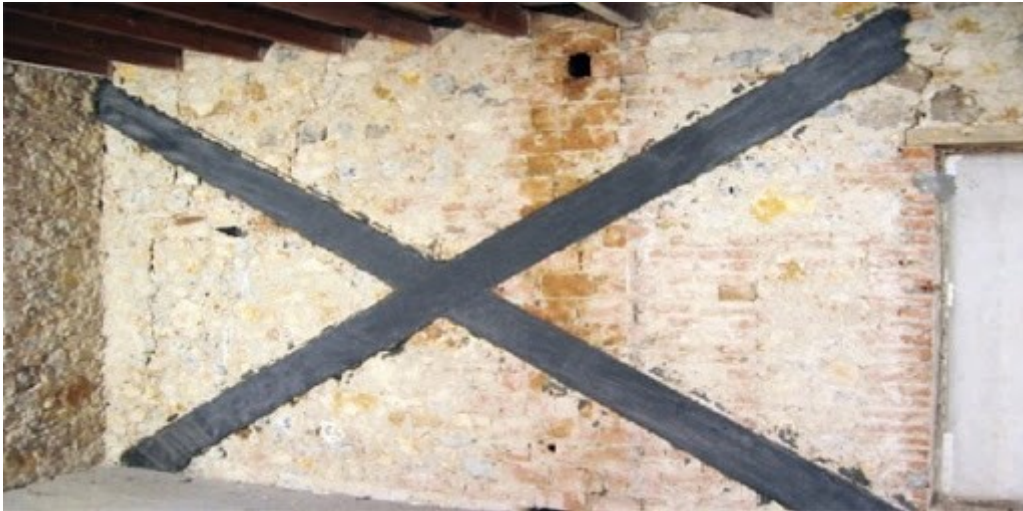
Figura 4.12 – Rinforzo di pannello murario con diagonali in FRP
