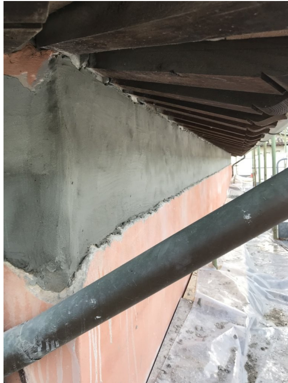
Figura 4.22 – Realizzazione strato di regolarizzazione della superficie di contatto tra rinforzo e muratura.
