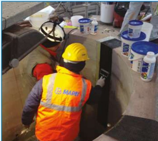
Rinforzo ciminiera in muratura con MapeWrap C UNI-AX System
