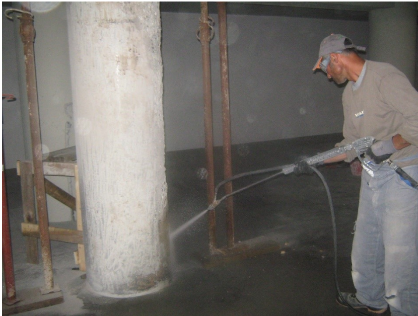
Figura 5.18 – Idroscarifica del calcestruzzo superficiale
