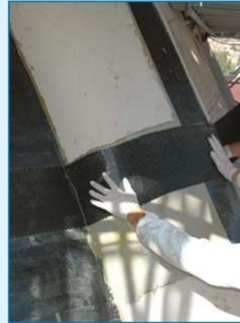
Rinforzo cupola in muratura con MapeWrap C UNI-AX System
