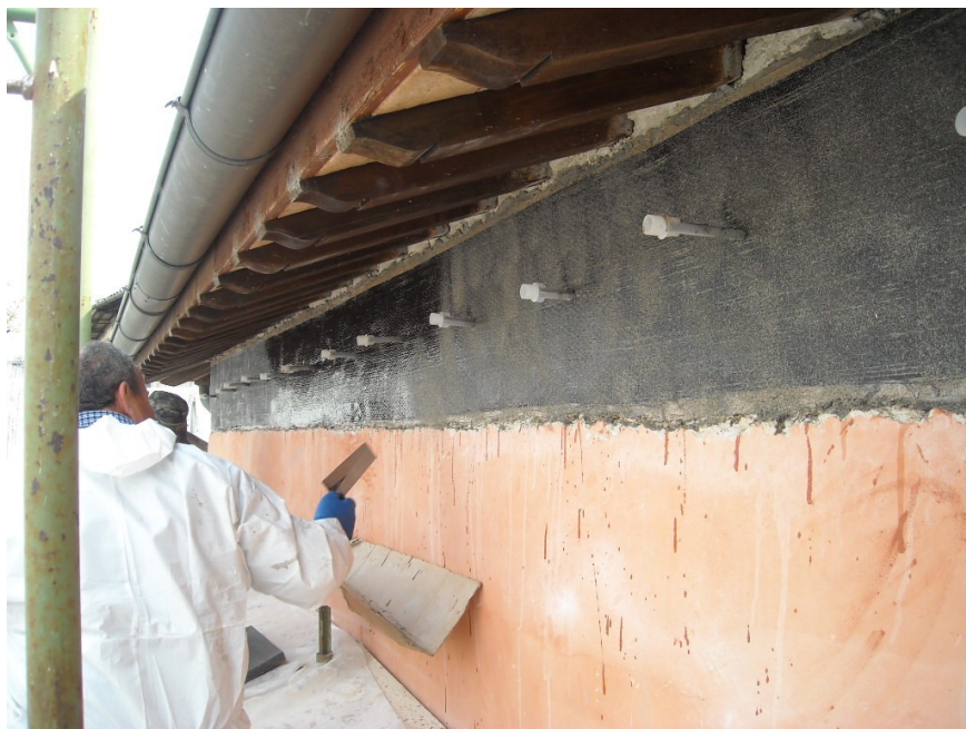
Figura 4.26 – Spruzzatura a mano di sabbia al quarzo
