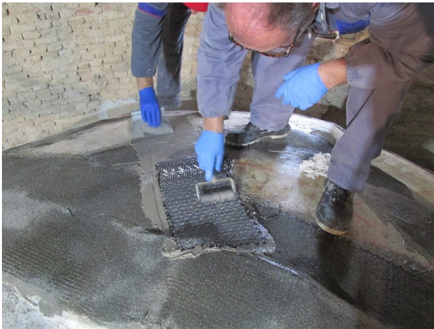
Figura 4.35 – Posa in opera di fascia in fibra di carbonio quadriassiale previa stesura di resina epossidica bicomponente
