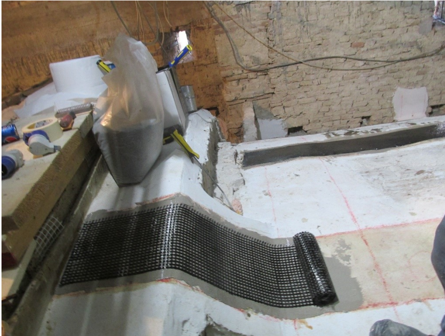
Figura 4.34 – Posa in opera di fascia in fibra di carbonio bidirezionale previa stesura di resina epossidica bicomponente
