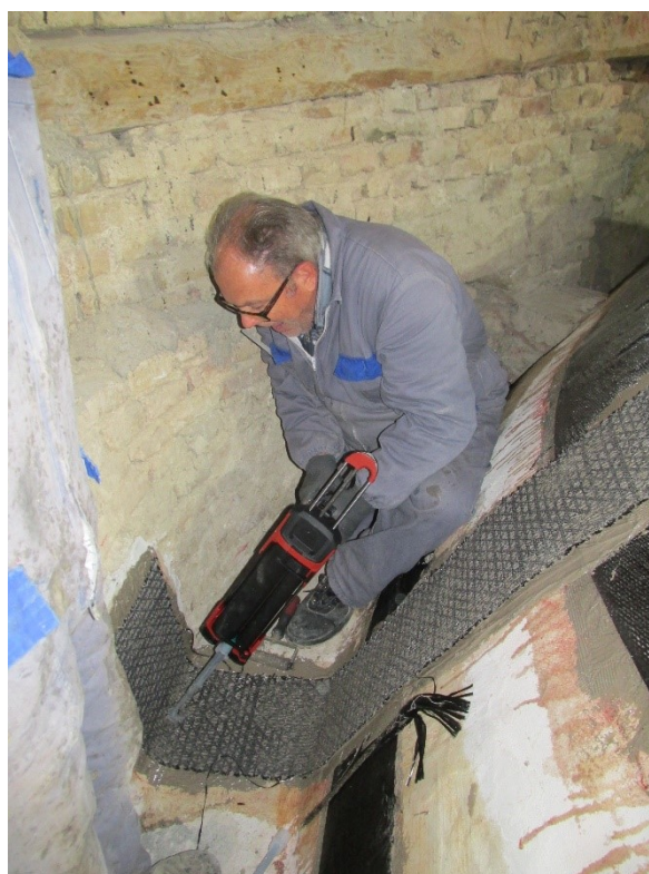
Figura 4.36 – Iniezione di resina epossidica in perforo
