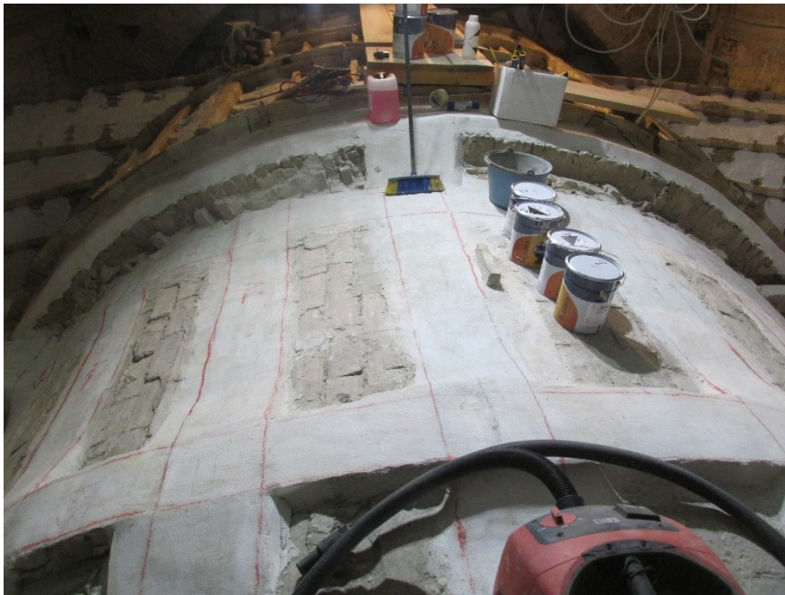
Figura 4.31 – Preparazione e regolarizzazione del substrato
