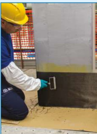
Applicazione del tessuto MapeWrap C UNI-AX impregnato con MapeWrap 31
