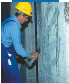
Preparazione del supporto
