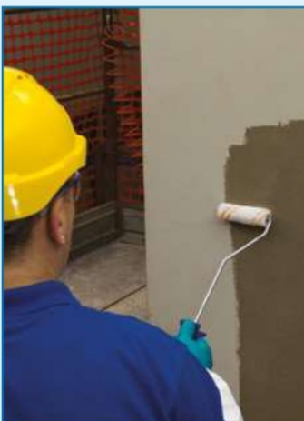
Applicazione di MapeWrap Primer 1
