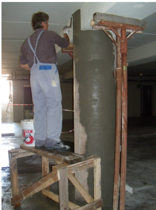
Figura 5.20 – Riprofilatura pilastro con malta cementizia bicomponente a ritiro controllato
