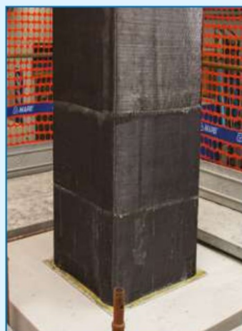
Pilastro confinato con MapeWrap C UNI-AX System
