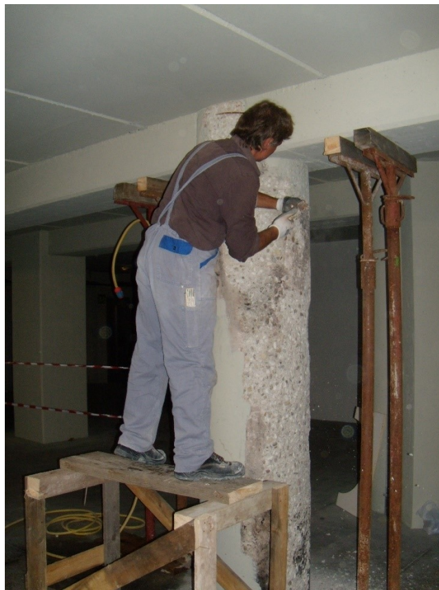
Figura 5.17 – Pulizia superficiale di calcestruzzo ammalorato
