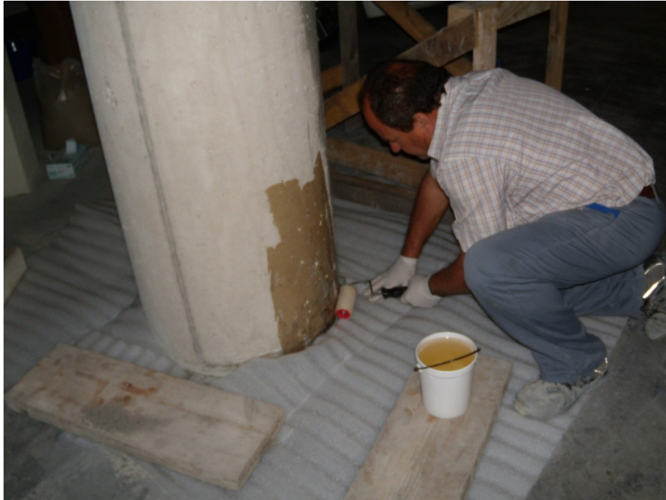
Figura 5.21 – Applicazione a rullo di primer epossidico
