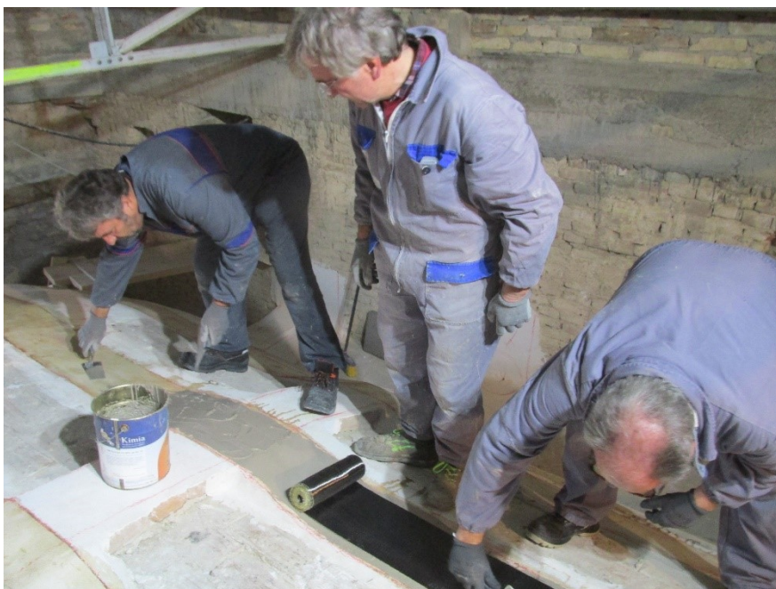
Figura 4.33 – Posa in opera di fascia in fibra di carbonio unidirezionale previa stesura di resina epossidica bicomponente
