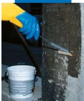
Applicazione della 2ª mano di MapeWrap Primer 1
