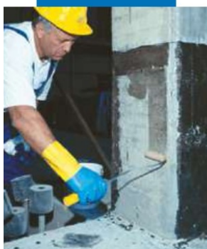
Applicazione della 1ª mano di MapeWrap Primer 1
