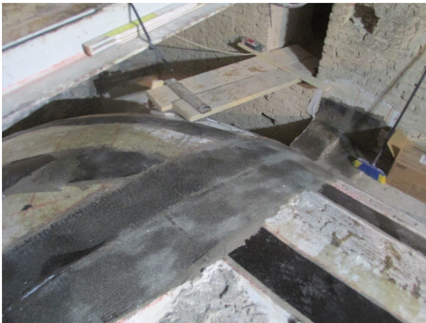
Figura 4.39 – Rinforzo di FRP a seguito della spruzzatura a mano di sabbia al quarzo
