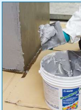
Rasatura con MapeWrap 11 o MapeWrap 12
