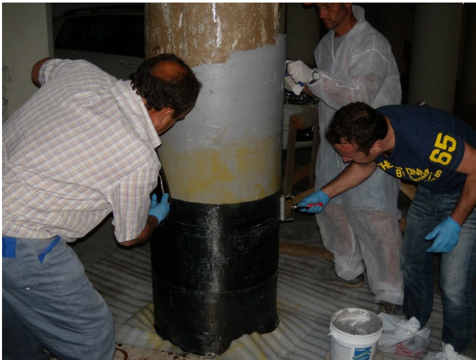
Figura 5.22 – Posa in opera di tessuto di rinforzo unidirezionale
