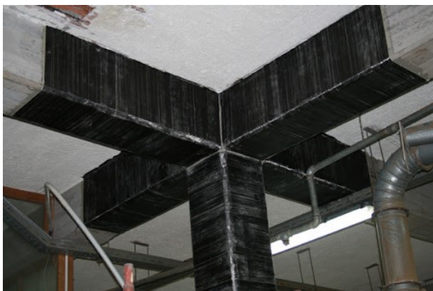
Figura 2.2 – Applicazione di FRP su struttura in calcestruzzo armato
