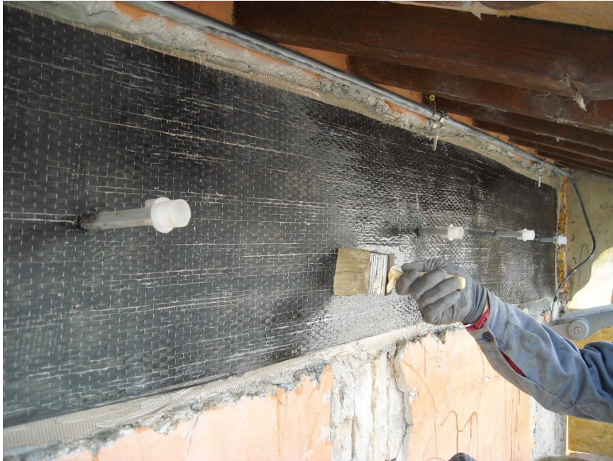
Figura 4.25 – Spennellatura di resina epossidica bicomponente
