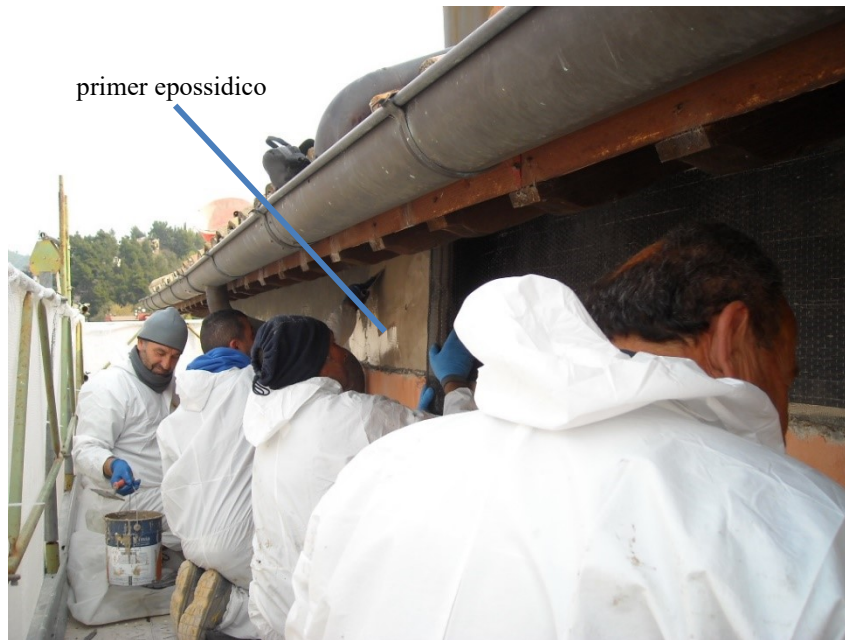
Figura 4.23 – Posa in opera di fascia in fibra di carbonio previa stesura di primer epossidico
