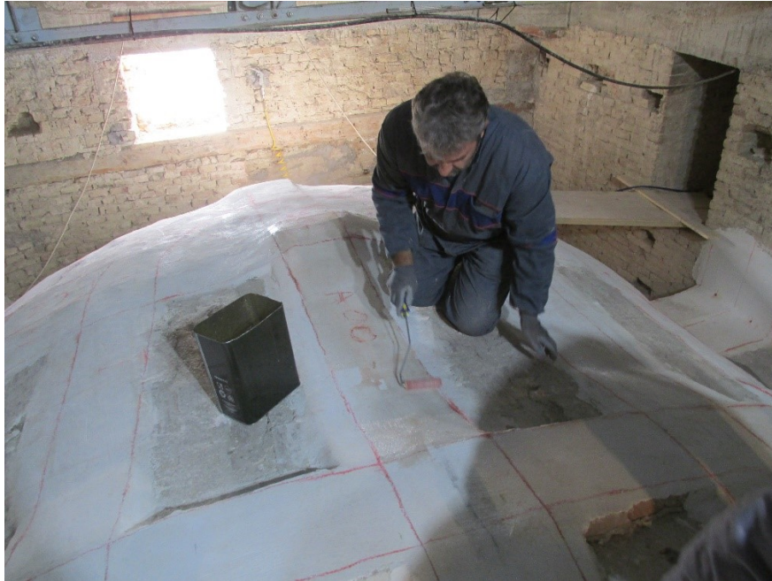
Figura 4.32 – Applicazione di primer epossidico bicomponente
