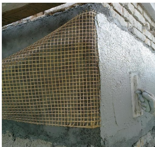
Figura 2.1 – Applicazione di FRCM su struttura in muratura
