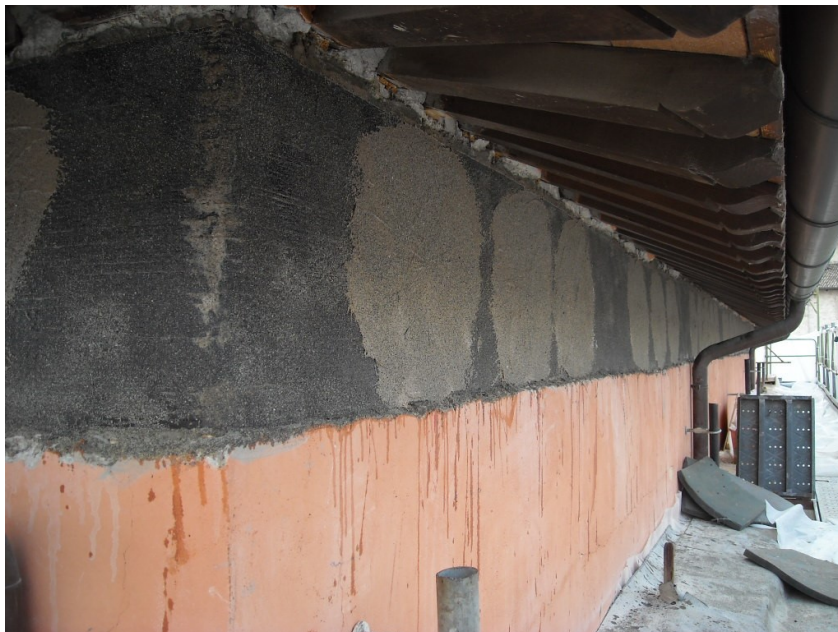
Figura 4.30 – Copertura focchi e spruzzatura di sabbia al quarzo
