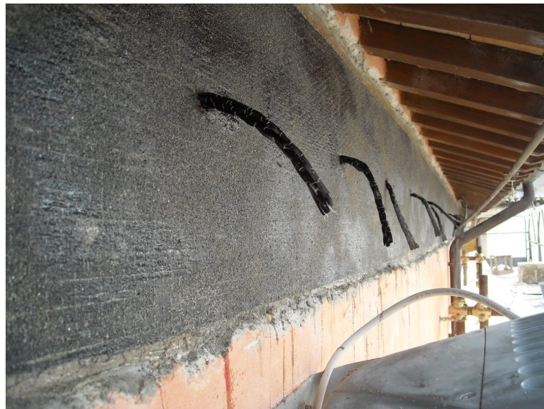
Figura 4.28 – Iniezione di connettori in fibra di carbonio
