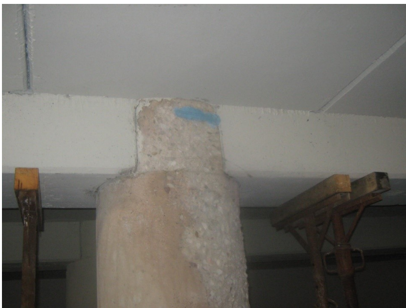
Figura 5.19 – Trattamento ferri per inibizione alla corrosione
