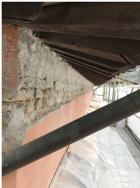
Figura 4.21 – Scalcinatura di intonaco e preparazione del substrato per la posa in opera del rinforzo FRP
