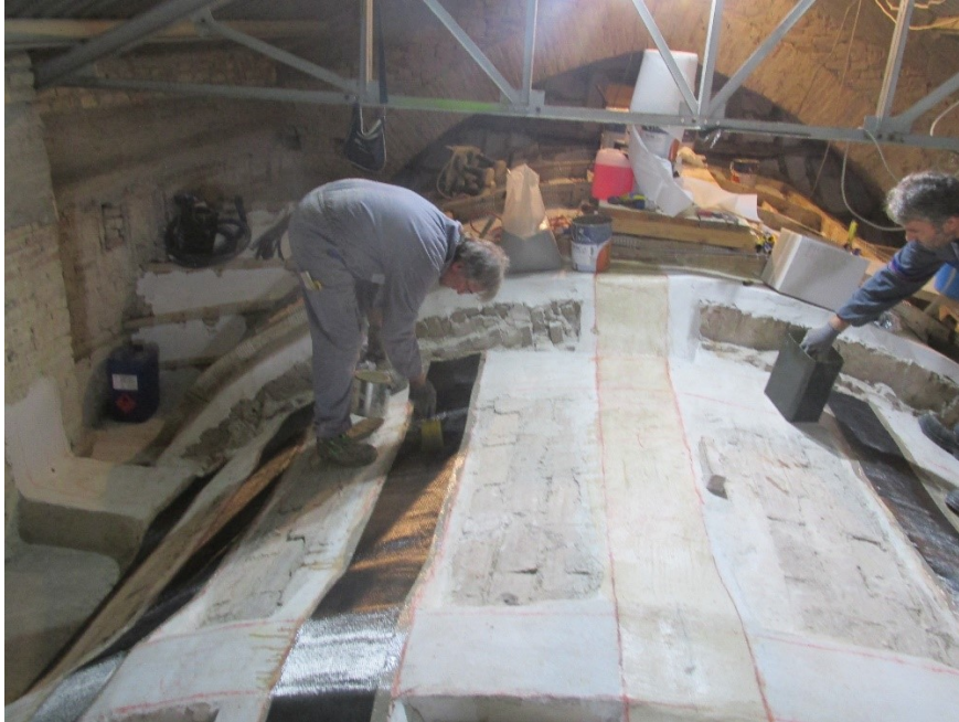
Figura 4.38 – Applicazione a pennello di resina epossidica impregnante su fascia di rinforzo FRP
