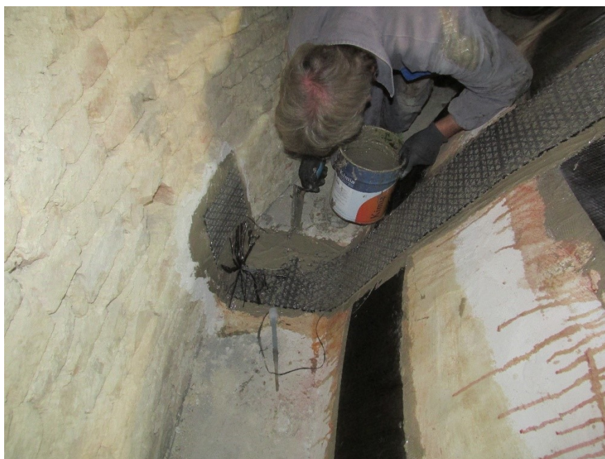
Figura 4.37 – Apertura e adesione fiocco con spatolatura di resina epossidica bicomponente
