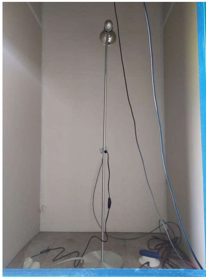
Figura 61 - Installazione lampada UV 100W nei box
