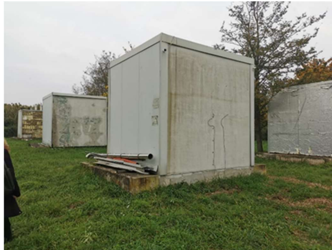
Figura 37 - Prefabbricato oggetto di studio
