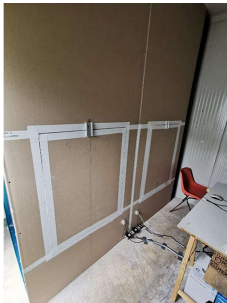
Figura 52- Allestimento sistema monitoraggio
