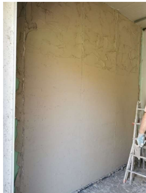
Figura 47 - Applicazione calce 2° strato
