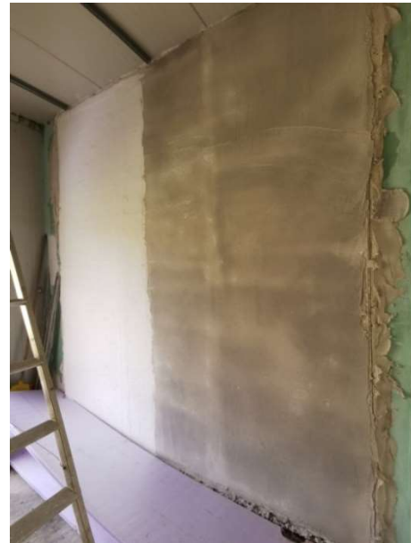
Figura 49- Applicazione finiture
