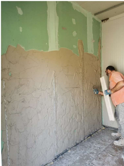
Figura 46 - Applicazione calce storica 1° strato
