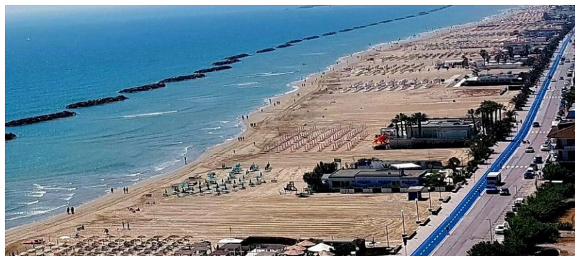
Fig.1.5 Protezione tramite frangiflutti emersi paralleli alla linea di costa (Porto San Giorgio).
