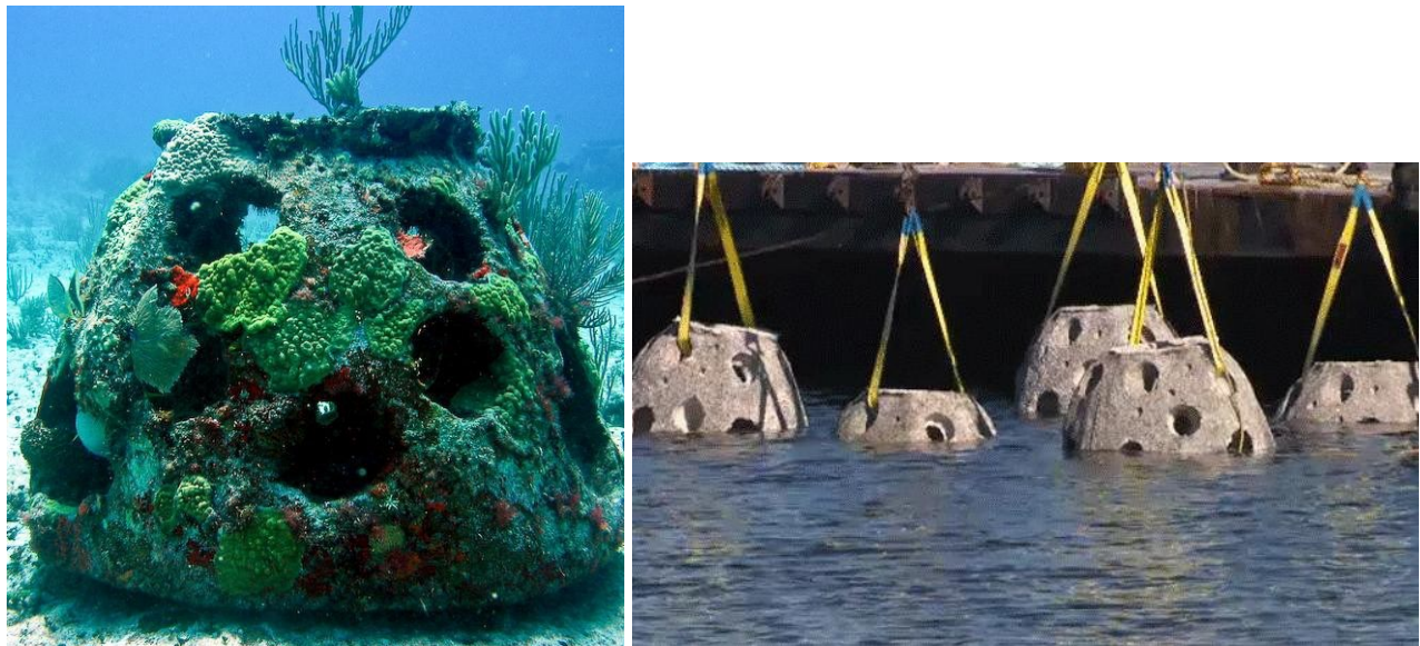
Fig. 1.8 Blocchi aquareef, dettaglio della posa in opera
