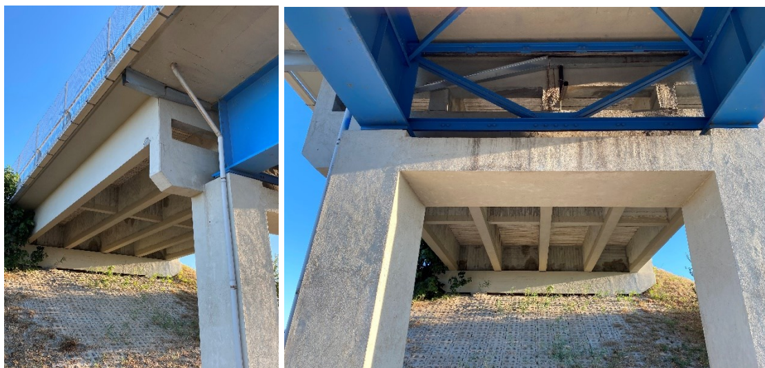
Figura 2.17 - Impalcato laterale e sottostrutture (cavalcavia 378)
