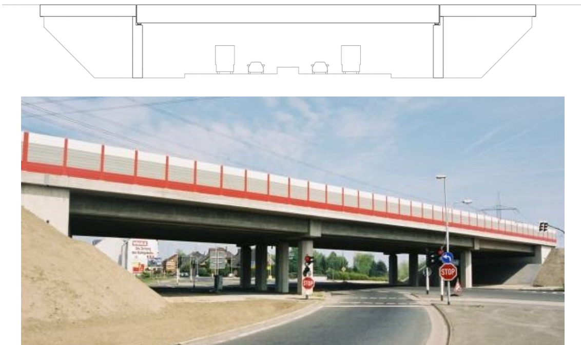
Figura 1.4 - Schema ed esempio di cavalcavia a travata con tre campate
