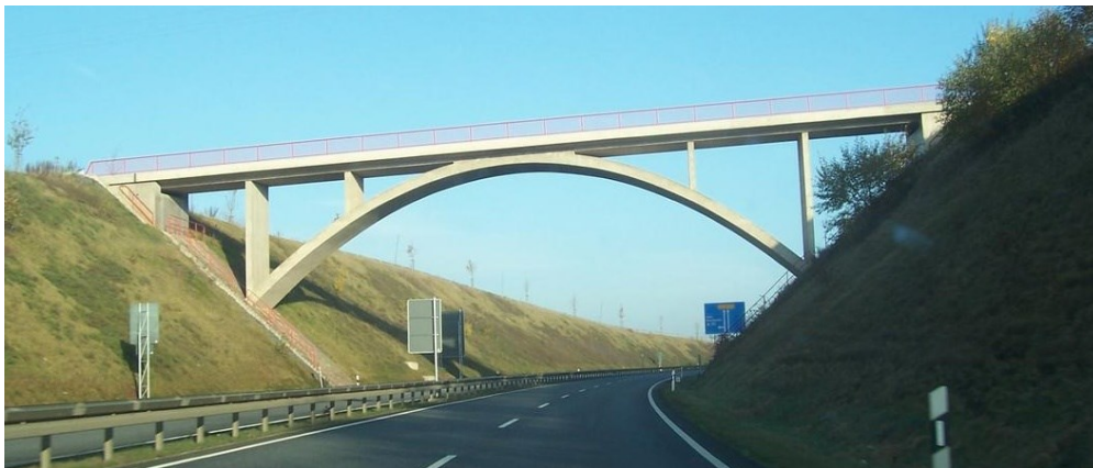
Figura 1.5 - Schema ed esempio di cavalcavia ad arco a via superiore
