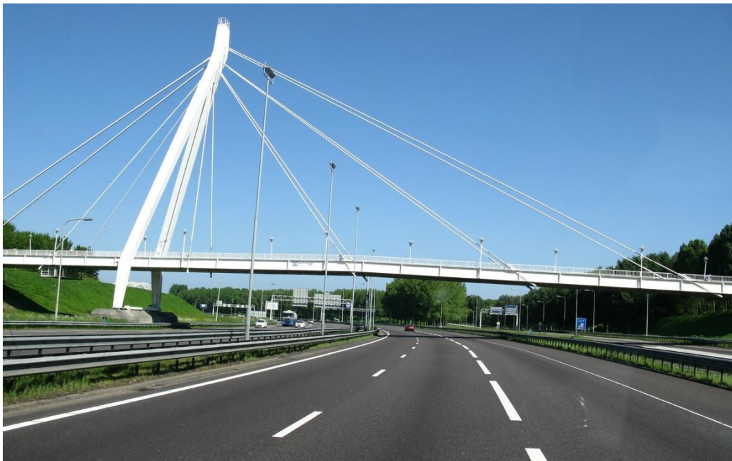
Figura 1.9 - Schema ed esempio di cavalcavia strallato
