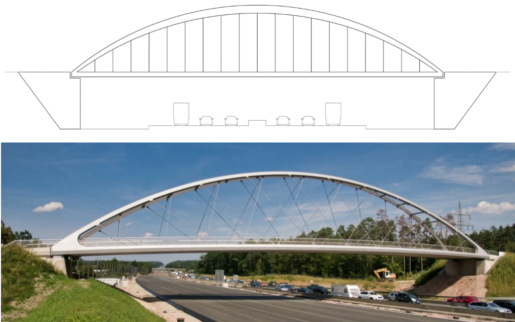
Figura 1.6 - Schema ed esempio di cavalcavia ad arco a via inferiore
