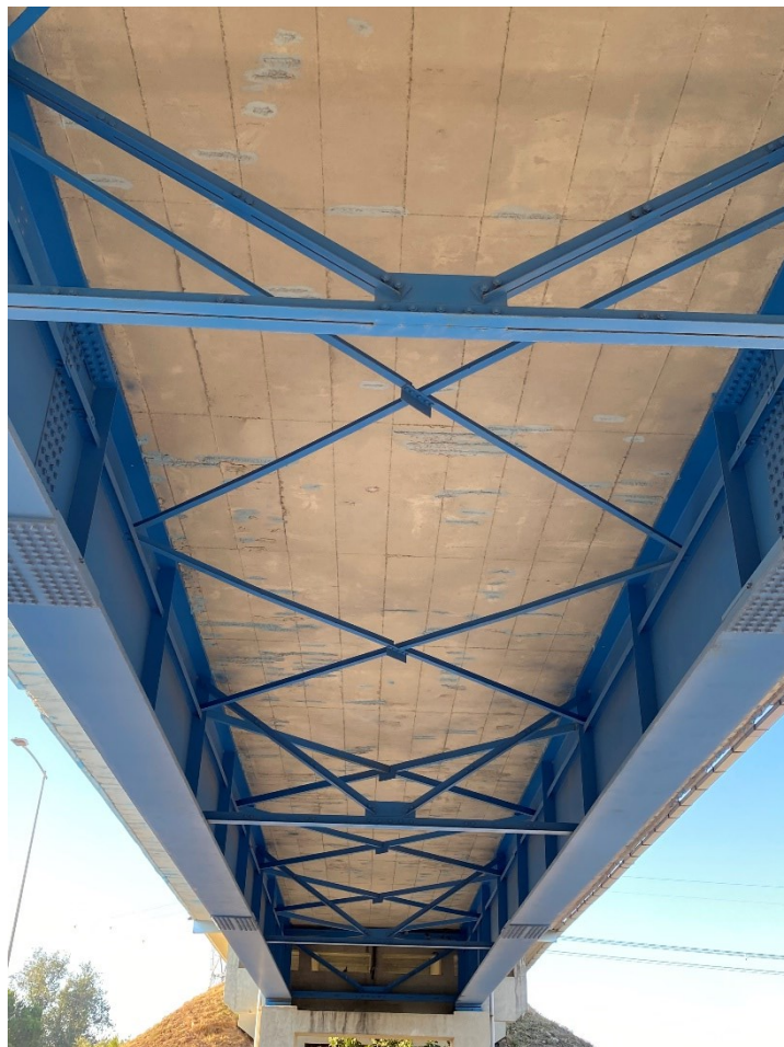
Figura 2.16 - Impalcato campata centrale (cavalcavia 378)
