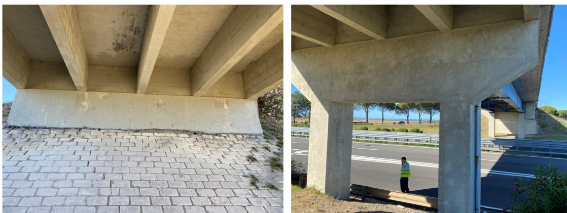
Figura 2.13 - Impalcato laterale e sottostrutture (cavalcavia 312)
