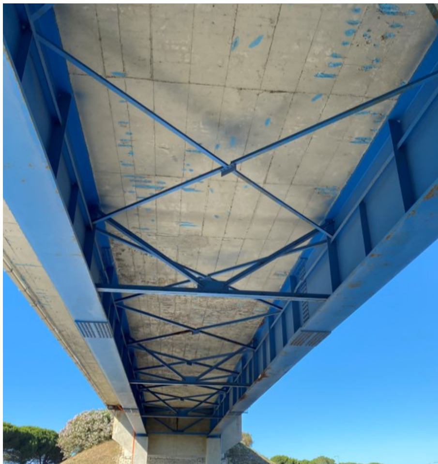
Figura 2.12 - Impalcato campata centrale (cavalcavia 312)
