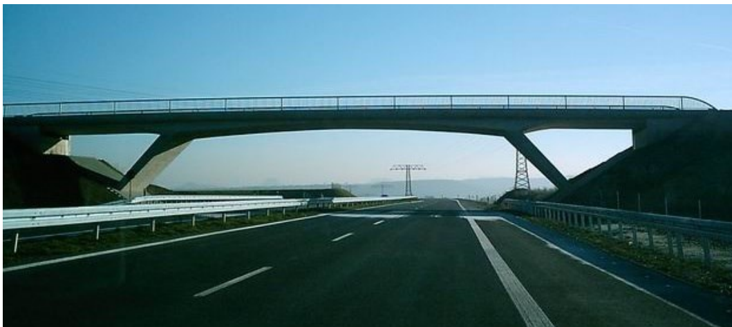
Figura 1.8 - Schema ed esempio di cavalcavia a telaio con piedritti inclinati
