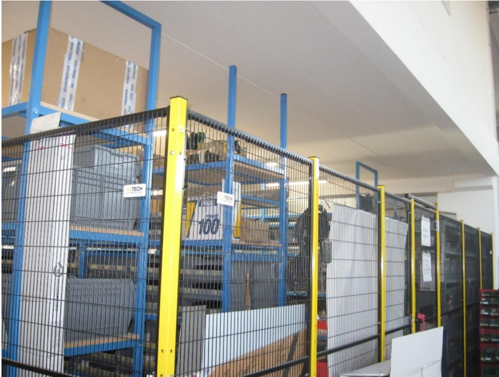
Figura 3.3.2 Esterno del magazzino Aumatech
