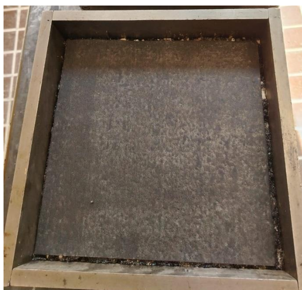
Figura 4.3 – Applicazione del geocomposito
