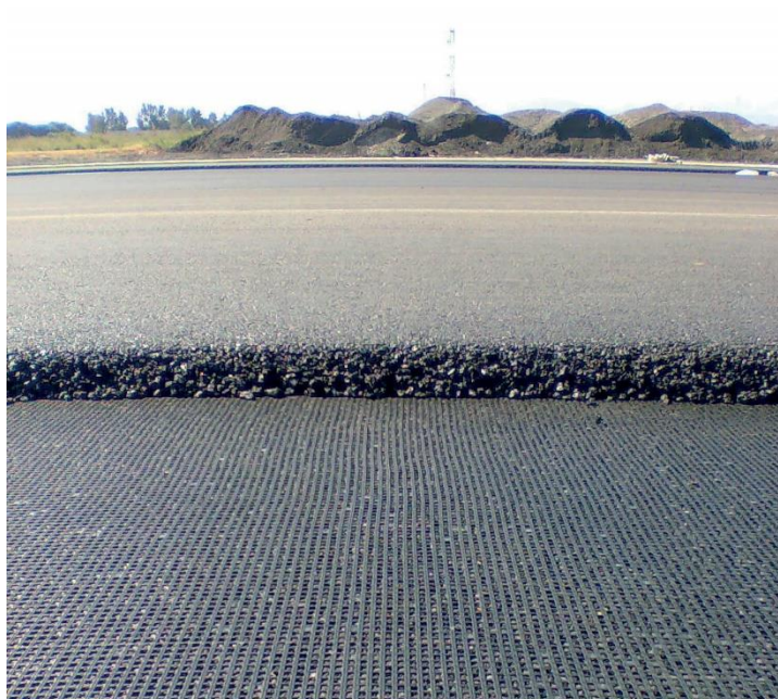
Figura 2.7 – Geocomposito messo in opera
