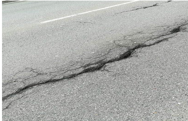
Figura 2.4 – Fessura longitudinale
