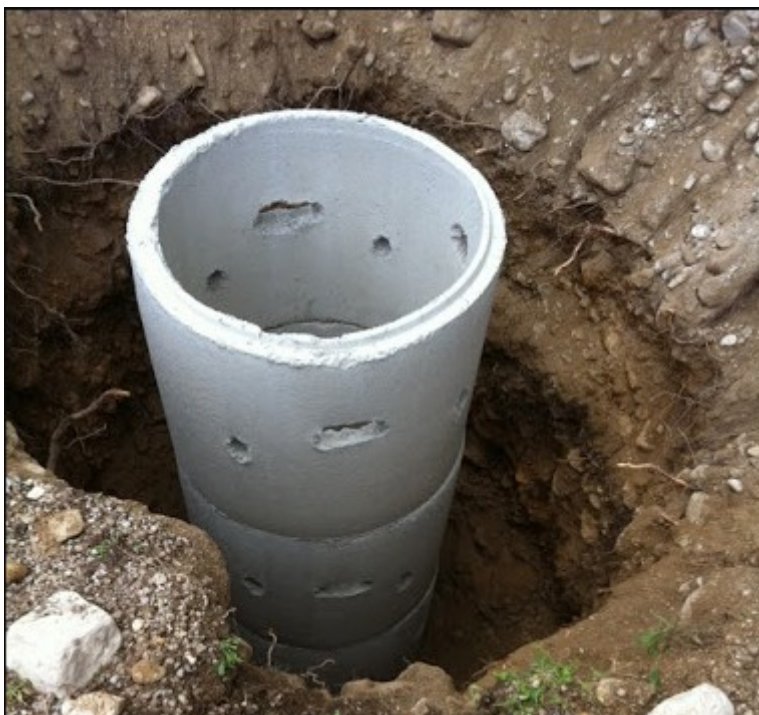
(Fig 1.13, Esempio di pozzo perdente per il drenaggio delle acque meteoriche: i fori sulle pareti permettono all'acqua di filtrare nel terreno circostante)
