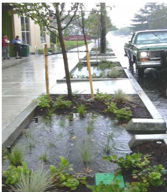
(Fig. 1.5a) Esempio di "infiltration planters", raccolgono l'acqua da marciapiedi e strade, la immagazzinano e riutilizzano per la vegetazione.
