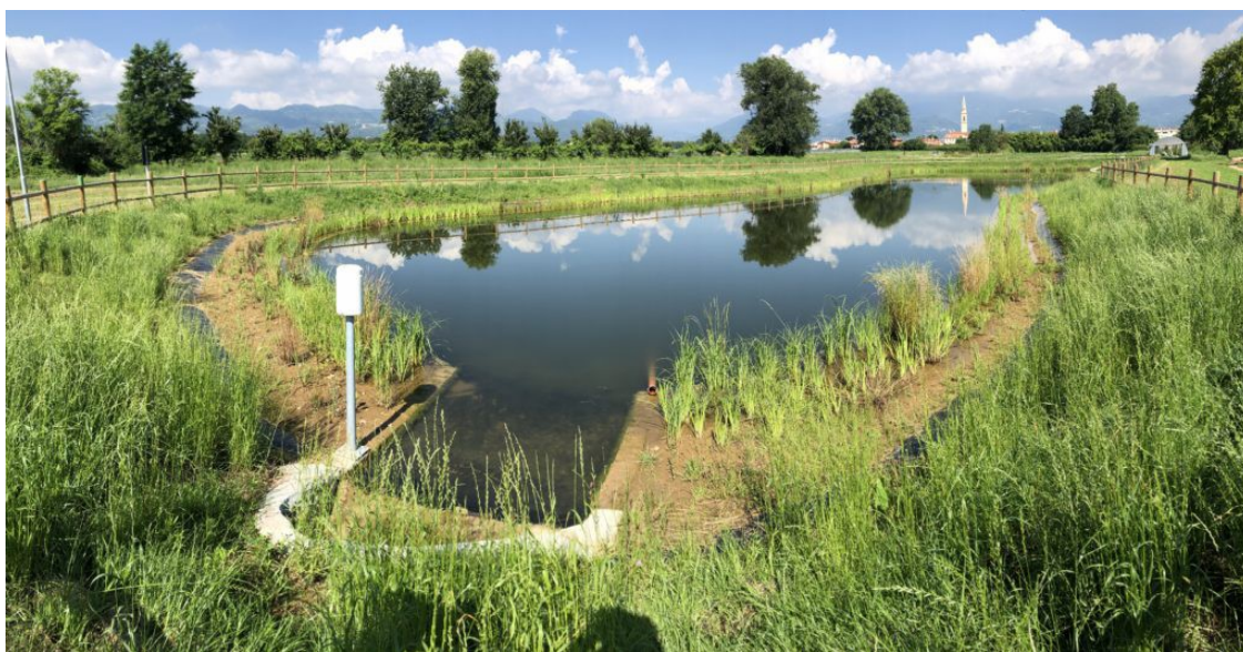
(Fig. 1.5c) Esempio di bacino di ritenzione, in cui vengono raccolte le acque di pioggia per la loro laminazione e infiltrazione
