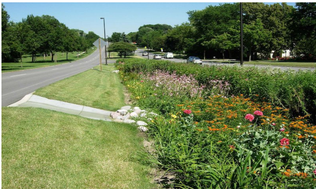
(Fig. 1.5b) Esempio di "bioswale", che oltre ad una funzione ecologica è anche in grado di trasportare grandi volumi d'acqua da un luogo all'altro.
