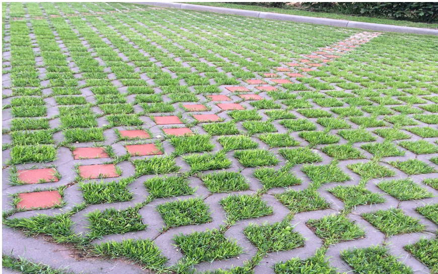
(Fig. 1.12, Esempio di pavimentazione porosa discontinua)
