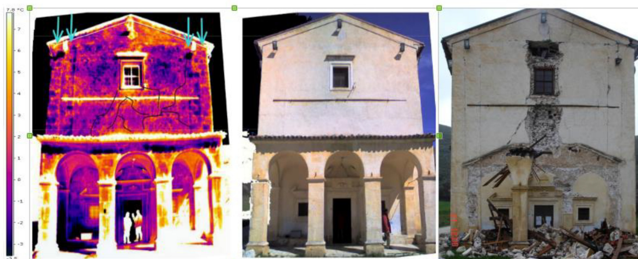
Figura 1: La chiesa di Santo Stefano di Sessanio, prima (a sinistra e al centro) e dopo (a destra) del terremoto del 6 aprile 2009. L'immagine termica era stata acquisita prima dell'evento sismico.
