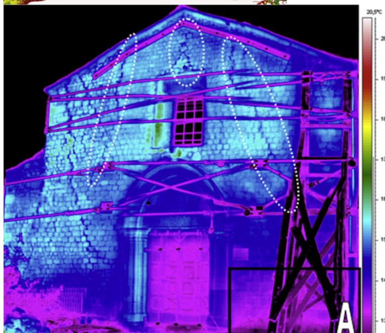
Figura 4: Termogramma della facciata dopo il terremoto, in cui si evidenziano le crepe visibili e il puntellamento dell'edificio.
