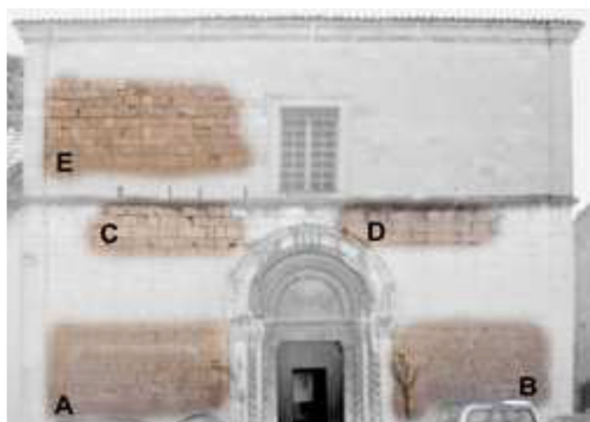
Figura 3: Identificazione delle varie zone critiche.
