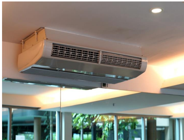
Figura 2.14 Ventilconvettore a pavimento e a soffitto [14]
