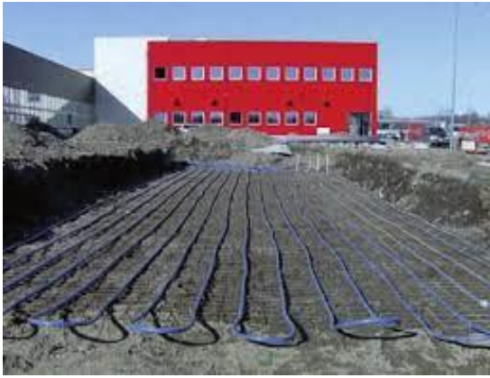
Figura 2.9 Installazione di scambiatori orizzontali in trincea a serpentina e in configurazione slinky [9]
