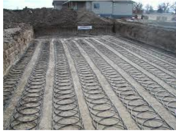
Figura 2.9 Installazione di scambiatori orizzontali in trincea a serpentina e in configurazione slinky [9]
