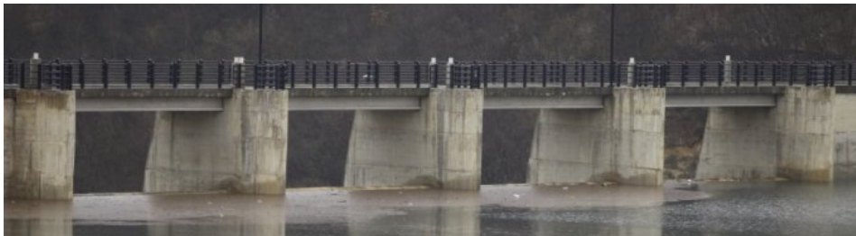
Fig. 58: Dettaglio degli sfioratori a stramazzo superficiali della diga di Castreccioni, tratto dal quotidiano "Cronache maceratesi".
