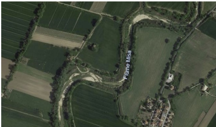
Fig. 53: Estratto da Google Earth di un tratto del fiume Misa a valle della confluenza, zona Bettollelle.
