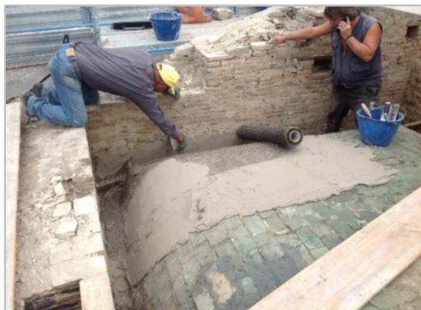
*Figura 5 - Rinforzo estradossale di volta in foglio mediante placcaggio diffuso con rete in fibra di basalto installata con malta a base di calce idraulica.*
