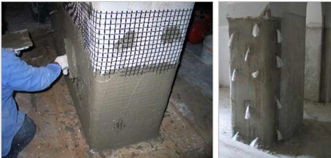
*Figura 11 - Confinamento di pilastro di muratura con rete di vetro AR*
