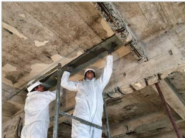
*Figura 13 - Rinforzo a flessione di trave mediante placcaggio con strisce di tessuto unidirezionale realizzate con rete di acciaio galvanizzato ad altissima resistenza e malta cementizia.*
