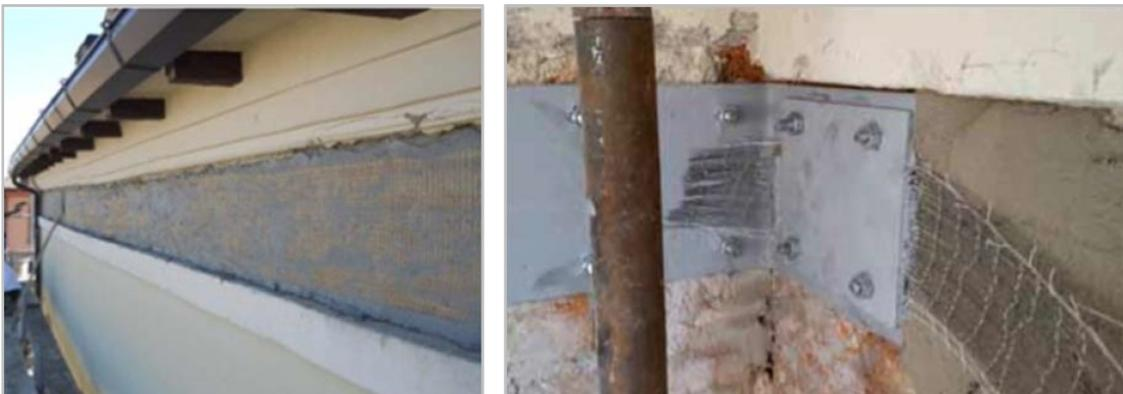
*Figura 9 - Cordolature di piano realizzate con tessuti di PBO e acciaio.*
