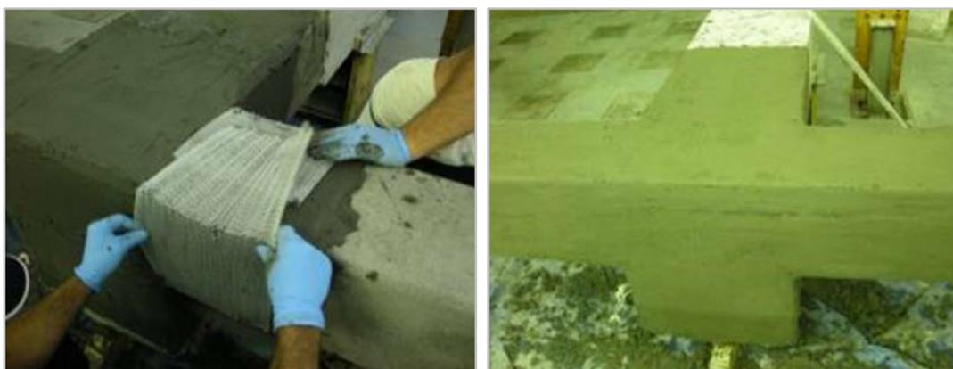
*Figura 18 - Rinforzo di nodi travi-pilastro con tessuto metallico galvanizzato unidirezionale e malta*
