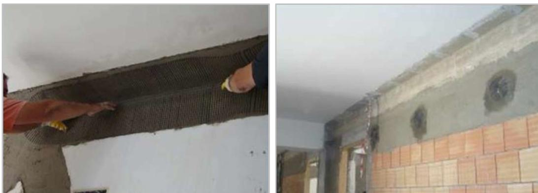
*Figura 22 - Presidio antiribaltamento delle tamponature con diversi tipi di reti e connettori*
