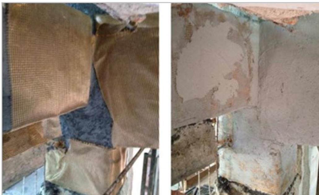
*Figura 17 - Rinforzo di nodi travi-pilastro*
