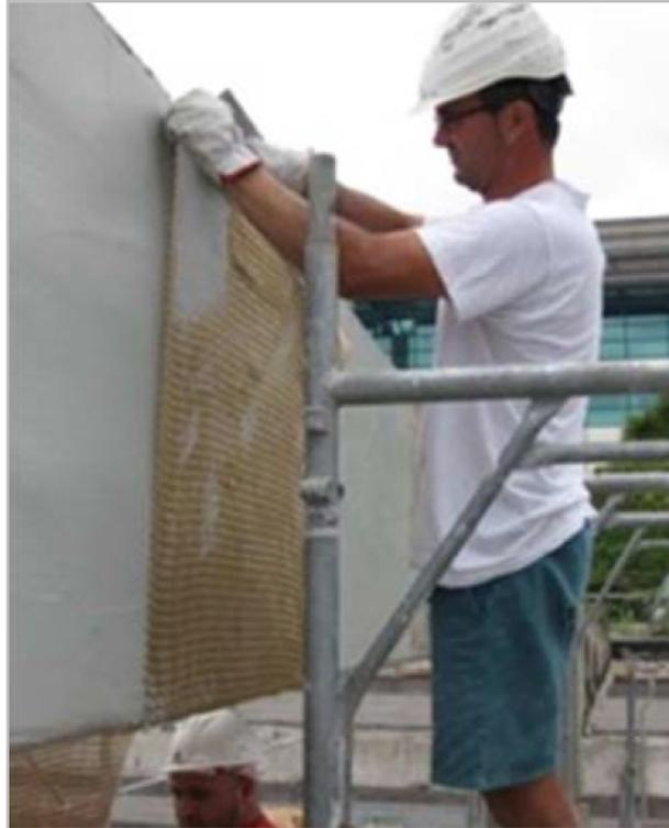
*Figura 14 - Rinforzo a taglio di una trave con rete di PBO*
