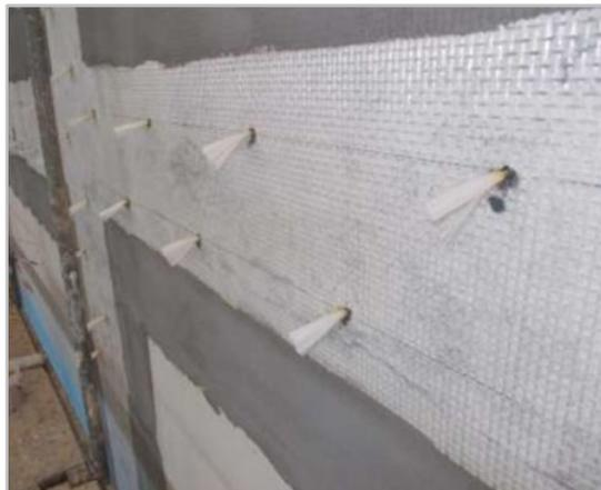
*Figura 21- Rinforzo antiribaltamento di pareti con un sistema FRCM, costituito da rete di fibra di vetro, malta, promotore di adesione e fiocchi di fibra di vetro.*
