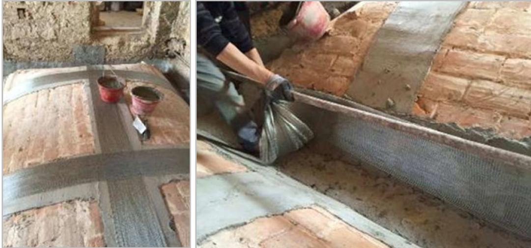
*Figura 6 - Applicazione di fasce di tessuto metallico galvanizzato unidirezionale e malta per il rinforzo estradossale di volte murarie.*
