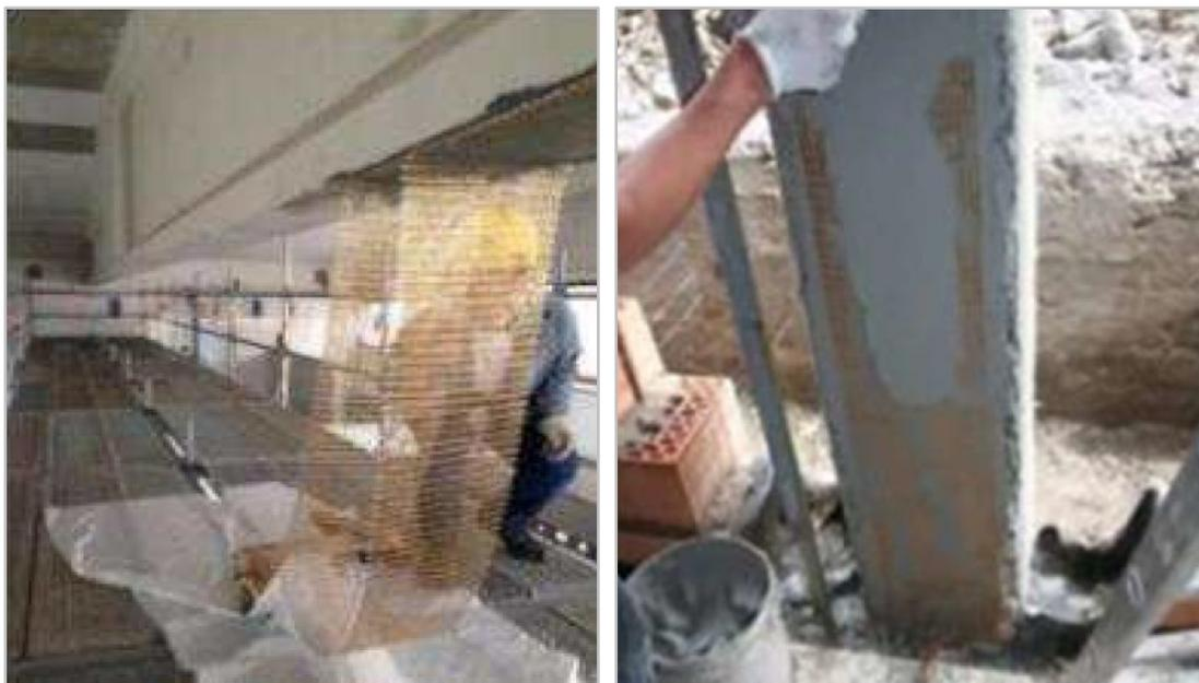
*Figura 12 - Rinforzo flessionale di una trave e di un pilastro con rete di PBO.*
