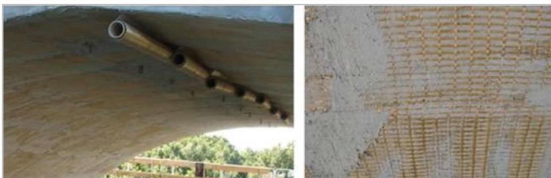
*Figura 23 - Rinforzo intradossale di un ponte ad archi in calcestruzzo con reti di PBO.*
