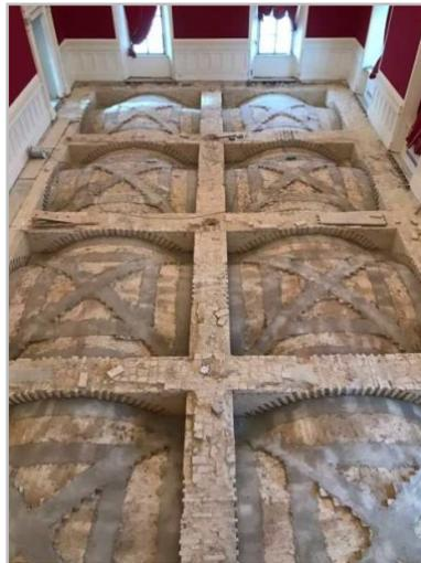
*Figura 7 - (a) Rinforzo intradossale di volta a padiglione mediante placcaggio di fasce di tessuto unidirezionale in fibra di acciaio galvanizzato ad altissima resistenza installate con malta a base di calce idraulica naturale; (b) Rinforzo estradossale di volte a crociera mediante placcaggio di fasce di tessuto unidirezionale in fibra di*
