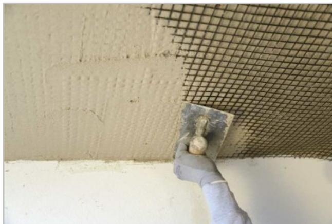
*Figura 20 - Rinforzo di un solaio (antisfondellamento)*
