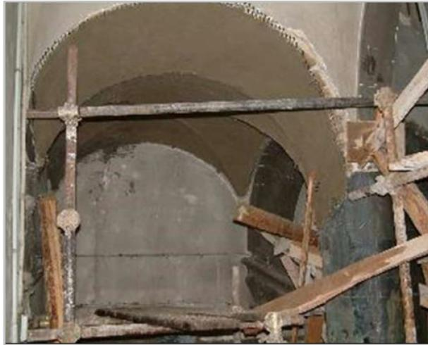
*Figura 8- Rinforzo intradossale di volta muraria con rete di fibra di vetro AR e malta*
