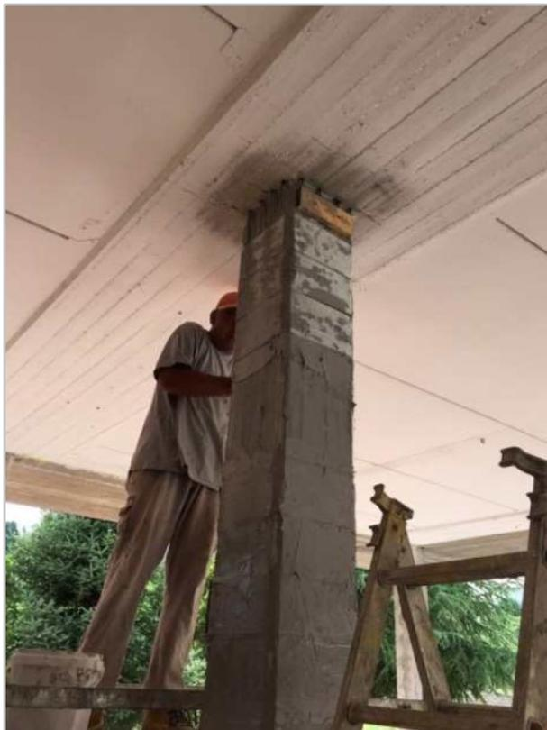
*Figura 15 - Cerchiatura di pilastro mediante tessuto unidirezionale realizzato con rete di acciaio galvanizzato ad altissima resistenza e malta cementizia.*
