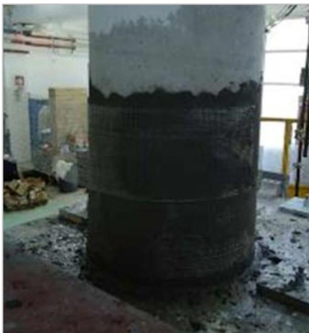
*Figura 16 - Confinamento di pilastro con tessuto metallico galvanizzato unidirezionale e malta.*
